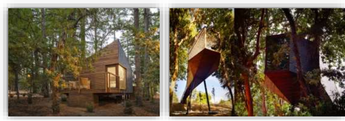
Figura 12 - À esquerda a Eco House e à direita a Tree House.
