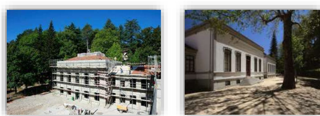
Figura 11 - Reabilitação do Edifício do antigo balneário termal das Pedras Salgadas.
