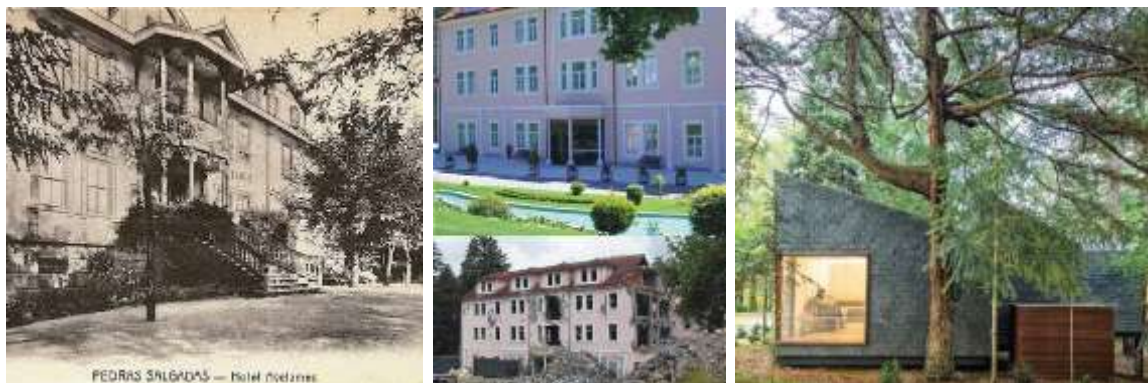
Figura 5 - Pedras Salgadas – Hotel Avelames, as várias fases históricas do edifício desde a sua origem, passando por uma reabilitação e por fim, a sua demolição. Veio dar lugar às “Eco-Houses.”
