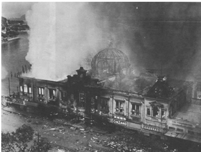
Figura 5 – Estação Cantareira incendiada, em maio de 1959
