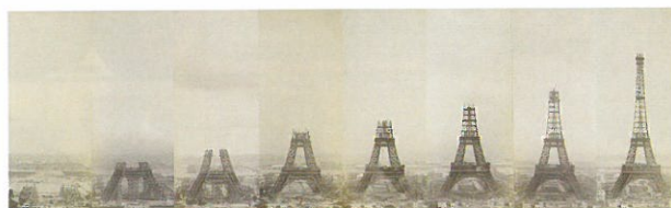
Figura 8. Montagem fotográfica com diferentes momentos evolutivos da construção da Torre Eiffel.
