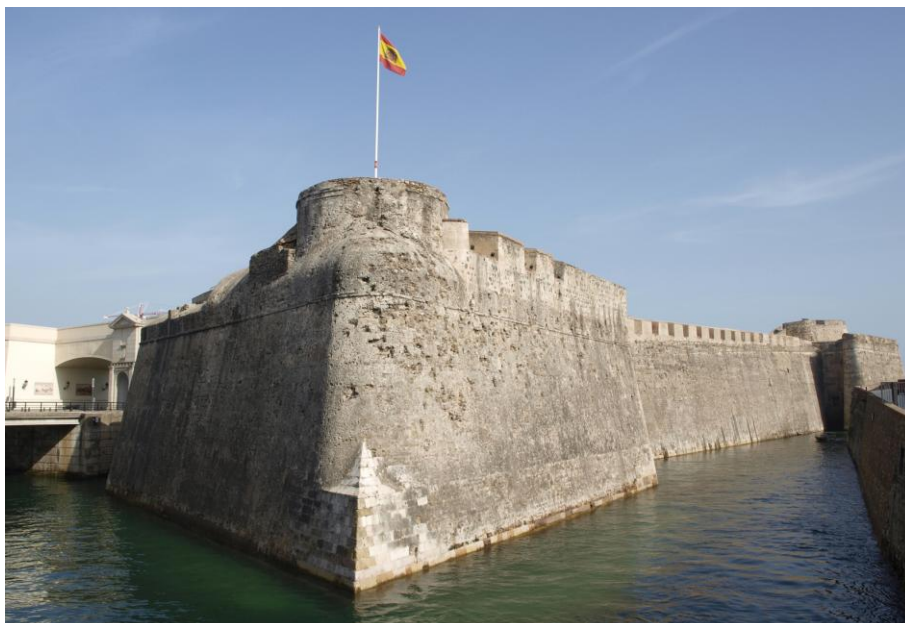
Fig. 17 – Fortificações luso-espanholas de Ceuta (Baluarte da Bandeira), protegidas pelo fosso real de S. Filipe.
