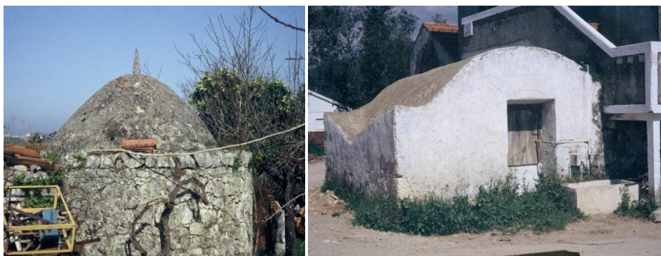
Figs. 15 e 16 – Cisternas com cobertura em abóbada de pedra, Casais de Santa Teresa, S. Vicente de Aljubarrota. Autor: A. Maduro
