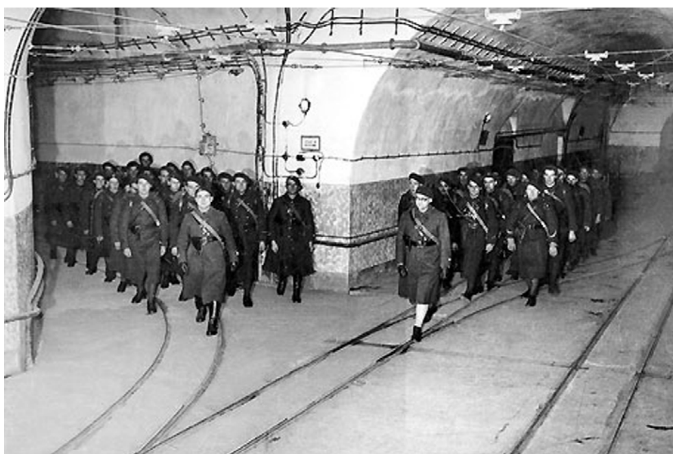
Fig. 27 – Tropas da guarnição nos túneis de um forte da Linha Maginot.
