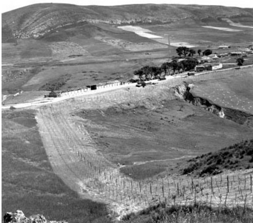
Fig. 1 – A barragem electrificada da Linha Morice na região fronteiriça de Bône (Annaba).
