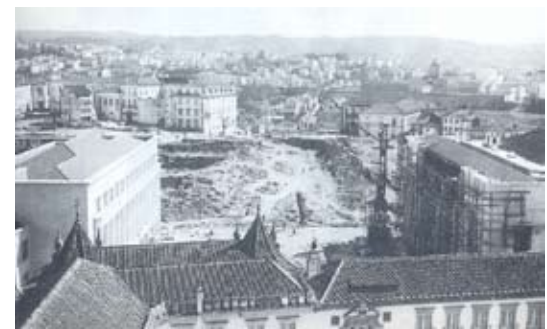
Alta antes da intervenção | Demolições durante o período de construção da Cidade Universitária
