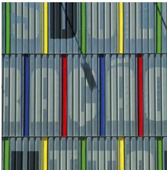
Centro Comercial Dolce Vita , Miraflora, Promontório Arquitectos, 2002. Fotografia do exterior | Pormenor da fachada
