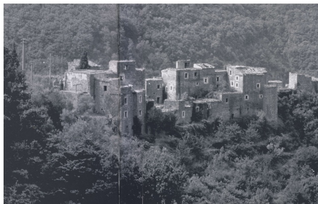
23. Vista da Colleta di Castelbianco
