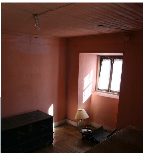
Fig 6. Interior de um dos quartos
