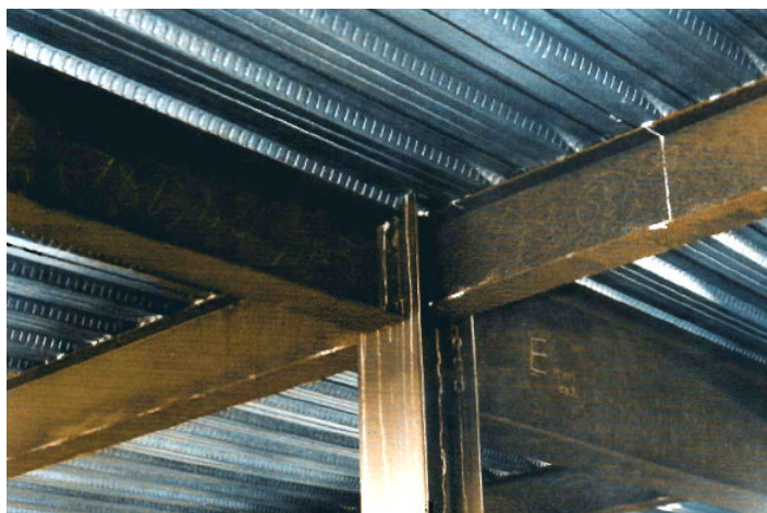
Figura 4 . Exemplo de junta com vigas de alturas distintas (ensaio de fogo: B.R. Kirby -British Steel Technical European Fire Test Programme - design, construction and results [6,1996])
