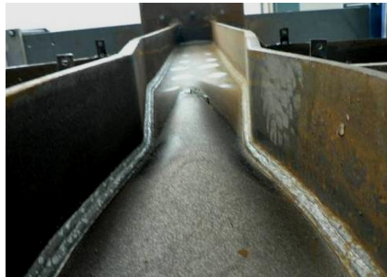
b) Vista longitudinal do pilar
