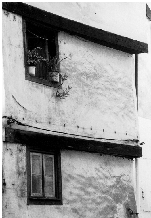
Fig. 7 - Pormenor do mesmo edifício Quinhentista na Rua do Sargento-Mor, a escassos metros da Praça e da Calçada.
