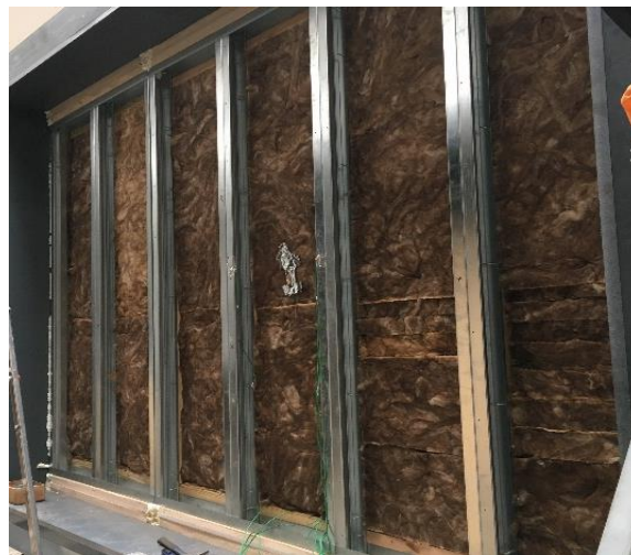
Figura 9. Interior da parede em LSF com lã de rocha na caixa-de-ar.
