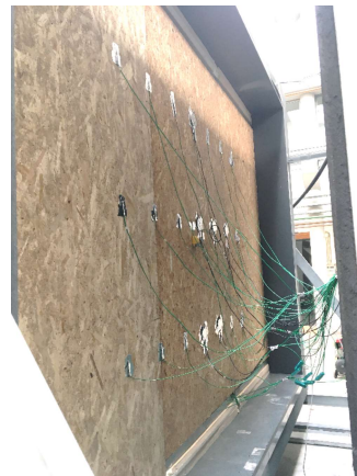
b) Parede instrumentada, lado frio
