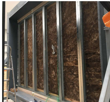
b) Lã de rocha na caixa-de-ar
