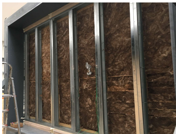
Fig. 1: Estrutura em LSF
