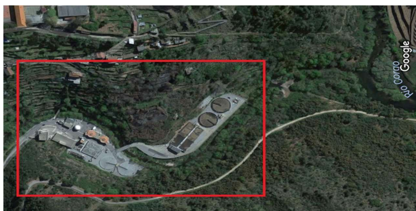
Figura 4.6 – Vista aérea da ETAR de Vila Real
