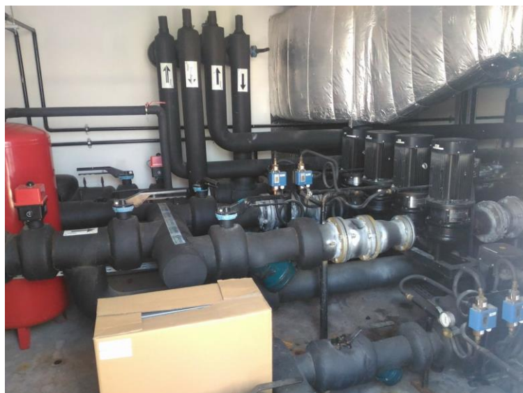
Fig. 16 – BRE e BDP instaladas na cobertura da BCS
