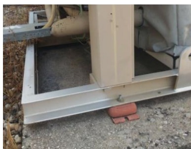
Fig. 26 – Borracha anti vibração do CH
