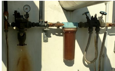
Fig. 24 – Filtro entupido
