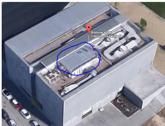
Fig. 22 – Local para a colocação dos painéis, na cobertura
