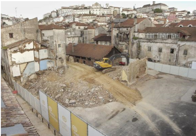
Figura 25 - Demolições da zona do Bota a baixo
