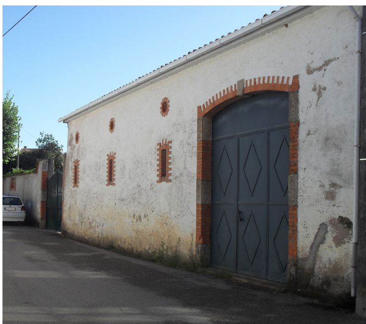
Fig. 75 - Fachada Poente (relação com a via de comunicação/estado actual) (Fotografia do autor)
