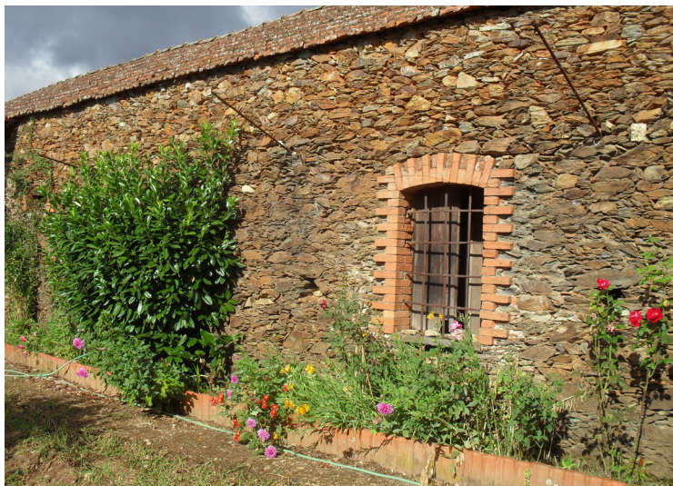
Fig. 74 - Fachada Nascente (estado actual) (Fotografia do autor)
