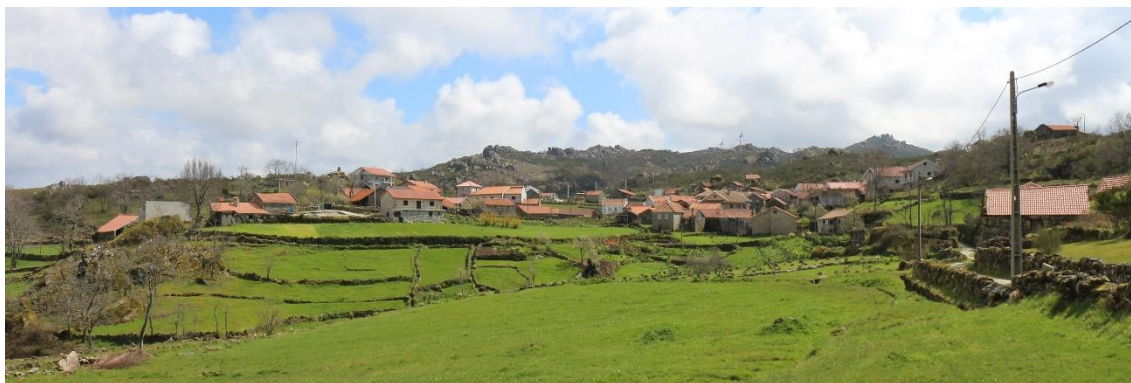
Figura 16_Aldeia de Alhões Figura 17_Aldeia de Bustelo da Laje Figura 18_Aldeia da Gralheira Figura 19_Aldeia de Vale de Papas
