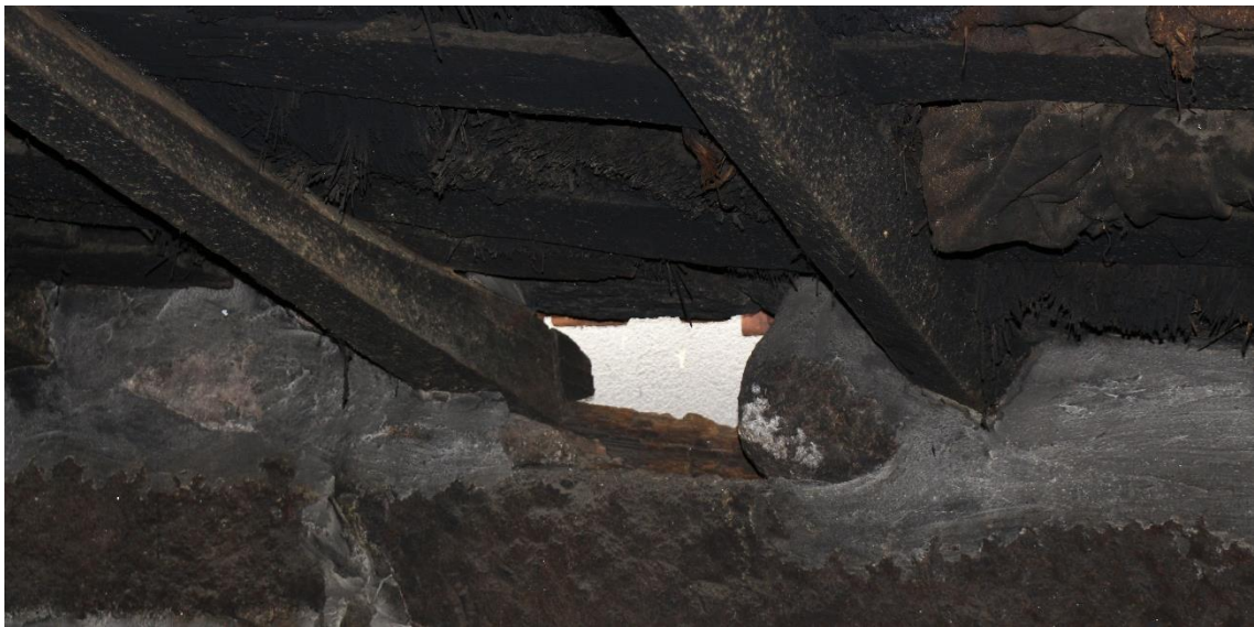
Figura 4_Habitacões. Figura 5_Espaço de ventilação.
