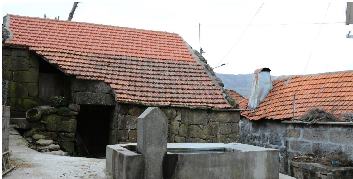
Figura 25_Casa de traça vernacular Figura 26_Habitação transformada em celeiro
