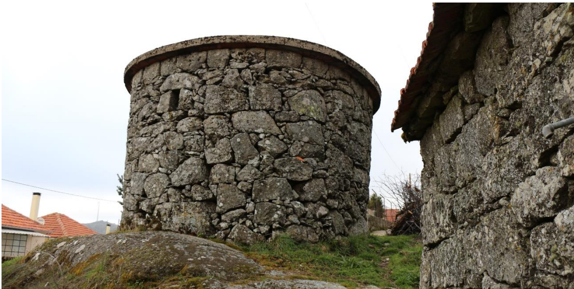
Figura 22_Acesso viário Figura 23_Escola básica Figura 24_Reservatório de água
