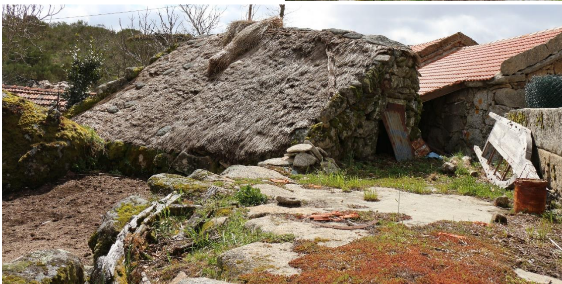
Figura 47_Forja Figura 48 e 49_Habitação desenvolvida em um e dois pisos Figura 50_ Construção em colmo
