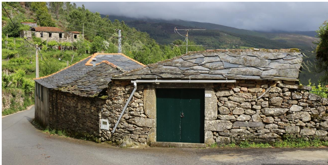
Figura 80_Vedação da propriedade Figura 81_Anexos agrícolas Figura 82_Habitação
