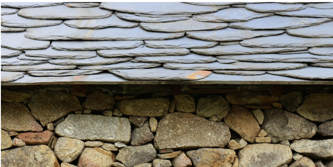
Figura 83_Edificação desenvolvida em dois níveis Figura 84_Composição da fachada Figura 85_Composição da cobertura
