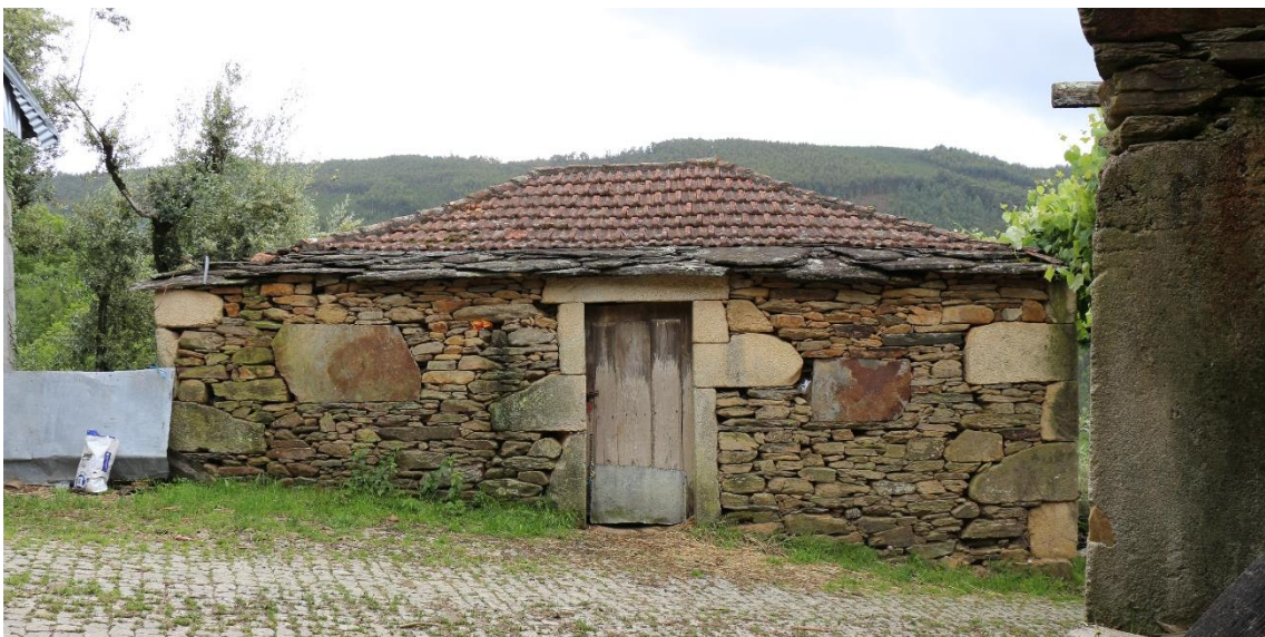
Figura 89_Construção em xisto Figura 90_Habitação Figura 91_Anexo agrícola
