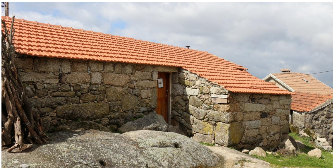
Figura 41_Currais Figura 42_ Espigueiro Figura 43_Atelier de artesanato
