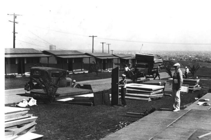
Figura 17 - Transporte das peças pré-fabricadas das cabanas da Aldeia Olímpica.
