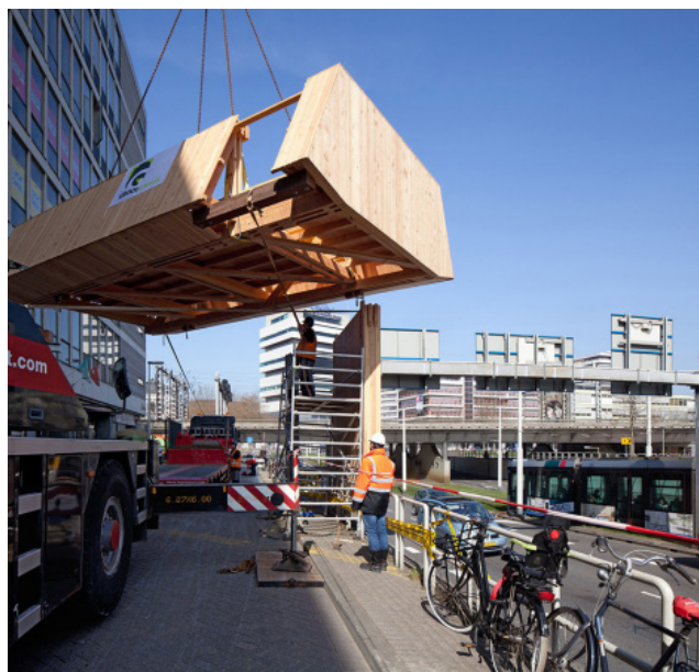
061 A montagem no local
