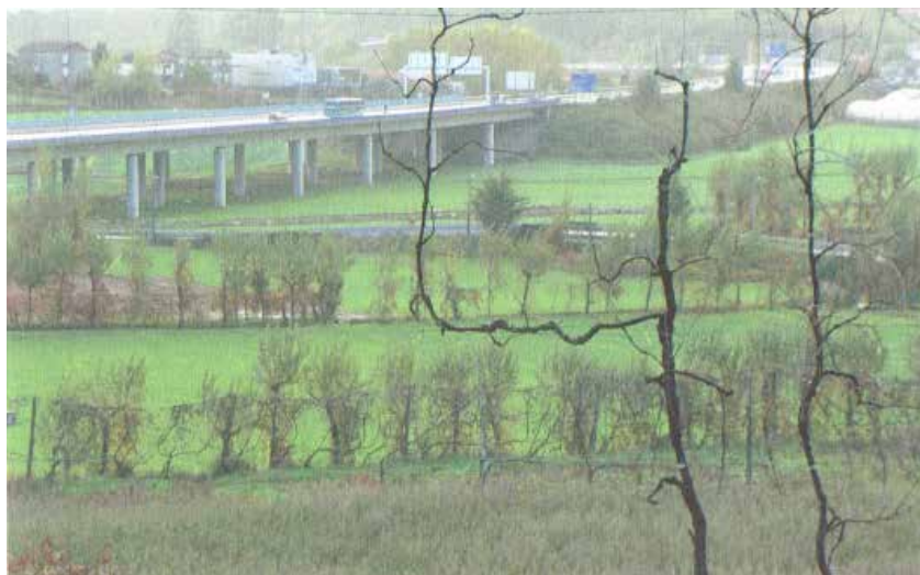
Fig. 64 Viaduto a atravessar os campos agrícolas
