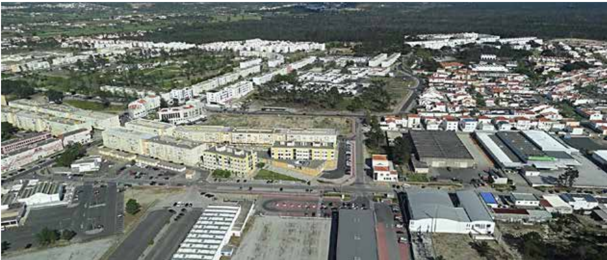
Fig. 51 Vista da Área Comercial e Zona Industrial Ligeira (ZIL)
