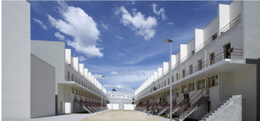
Fig. 43 Bairro da Bouça no Porto
