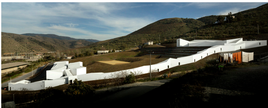
Fig.20 Centro de Alto Rendimento de Remo do Pocinho
