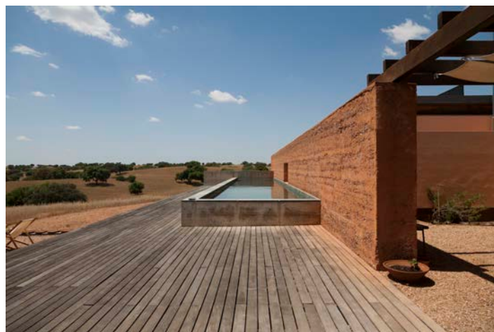
Fig.7 Casa em Taipa
