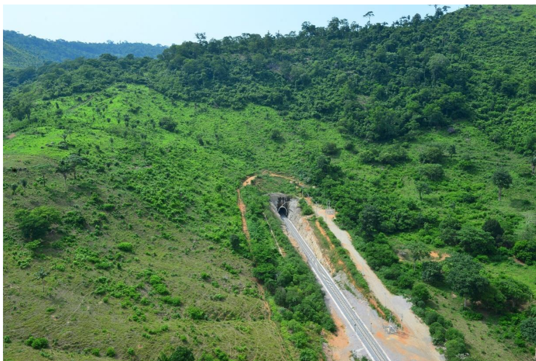
Figura 5-11 Visão geral do emboque norte do Túnel 0. (Crédito: Salviano Machado, Vale S.A.).
