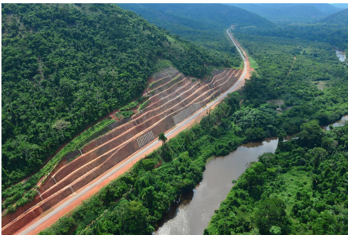
Figura 5-2 Visão geral do corte na estaca 56. (Crédito: Salviano Machado, Vale S.A.).
