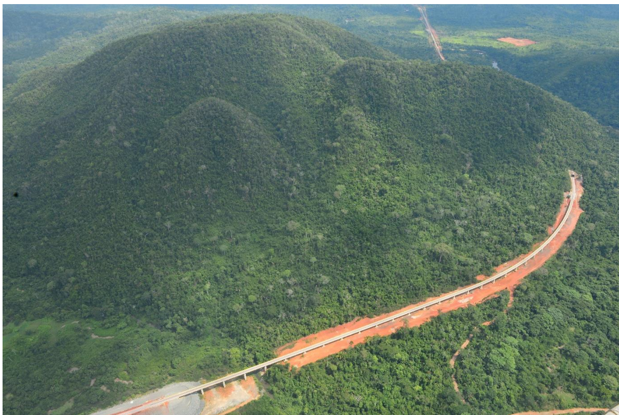
Figura 5-7 Visão geral da ponte sobre o rio Sossego e o trecho em viaduto na área da Floresta Nacional de Carajás até o Túnel 3 (Crédito: Salviano Machado, Vale S.A.)
