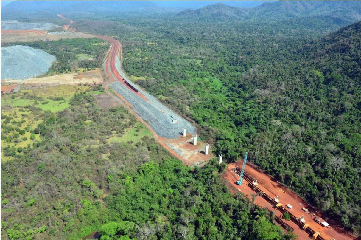
Figura 5-9 Visão geral do aterro do encontro E2 da ponte sobre o rio Sossego. (Crédito: Salviano Machado, Vale S.A.).
