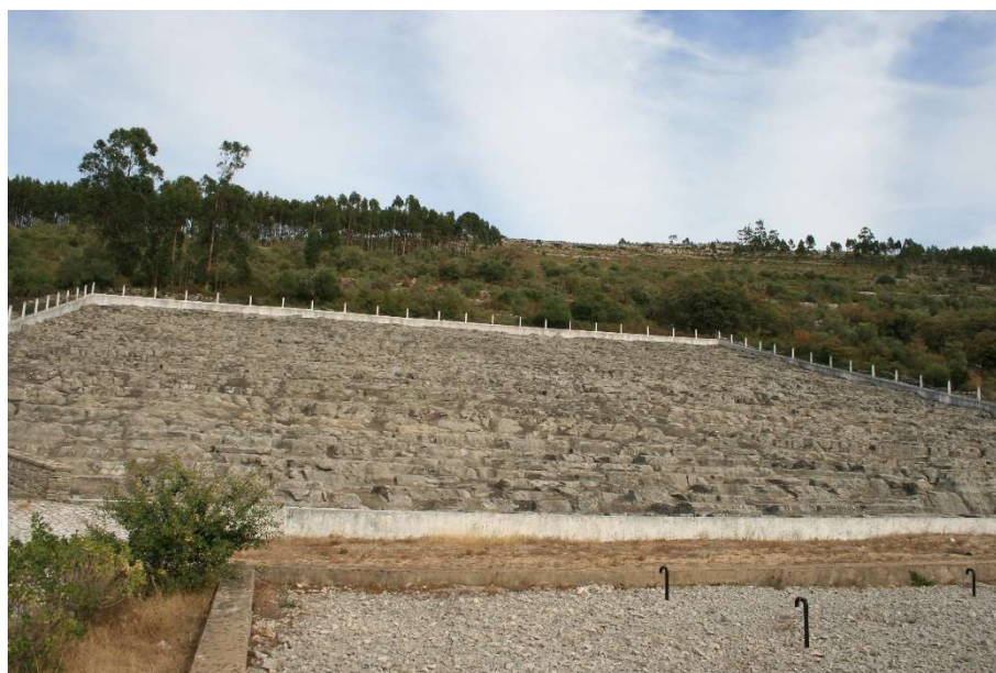
Figura 52: Telhados d'Água, Serro Ventoso.
