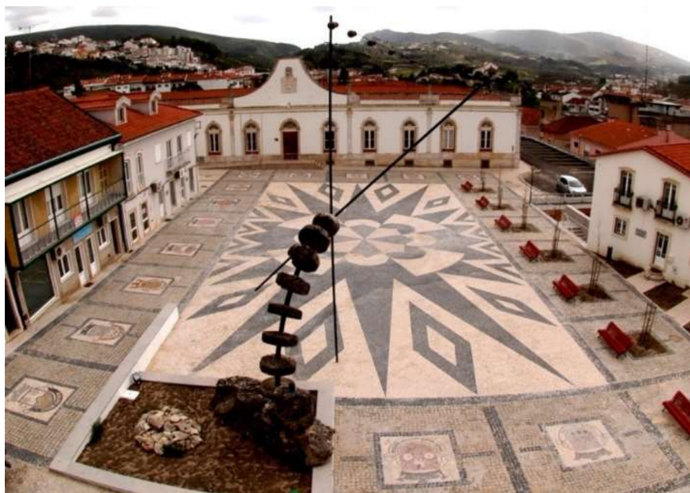
Figura 38: Exemplo de trabalho em calçada portuguesa, Praça da República, Porto de Mós.
