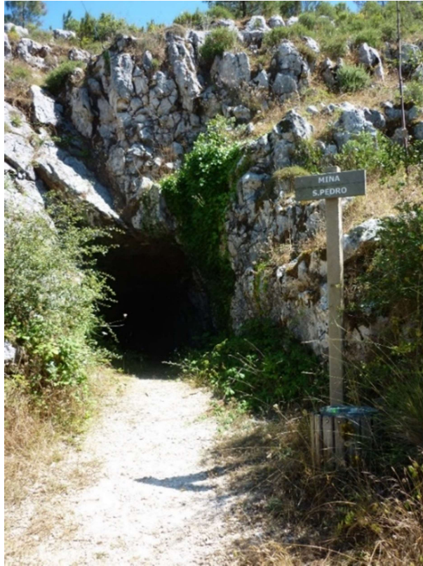
Fig. 27: Boca da Mina da Bezerra (Galeria de São Pedro).
