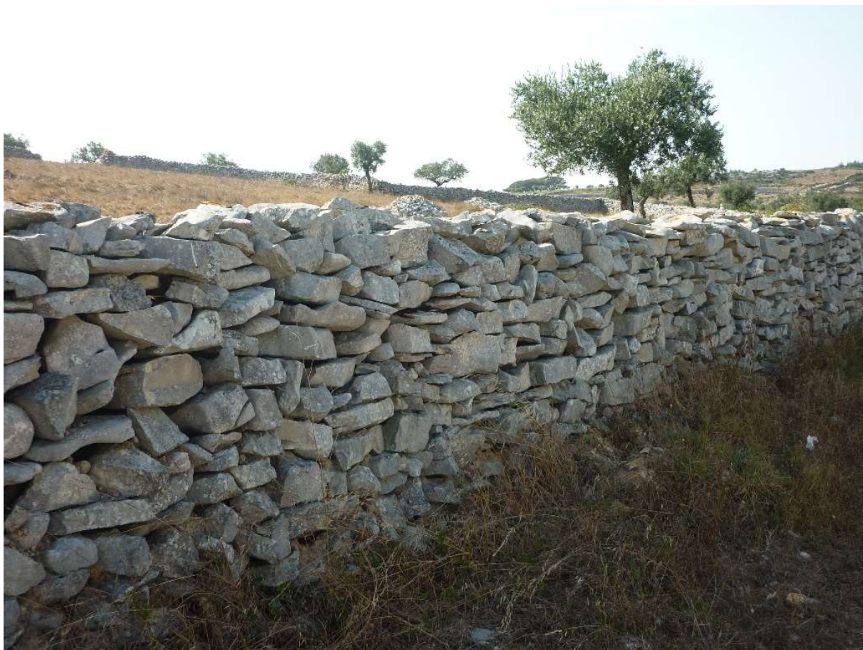
Figura 42: Muros de pedra seca, São Bento.
