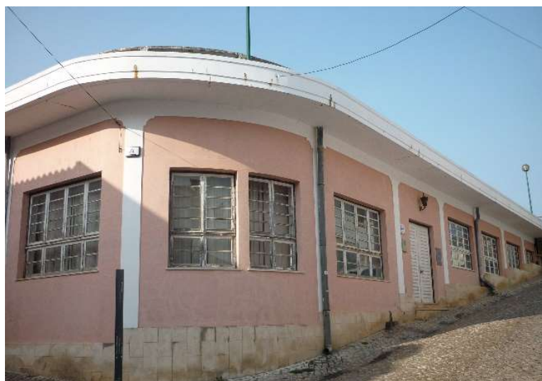
Fig. 12: Museu Municipal de Porto de Mós, fachada.
