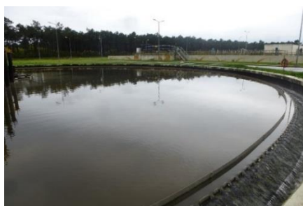
Figura 3.9 – Decantador secundário A. (ponto F9)
