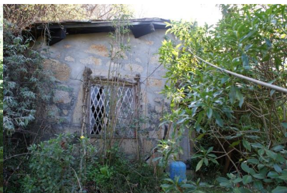
Figura 16 – Casa de Ferramenta – casa de apoio
