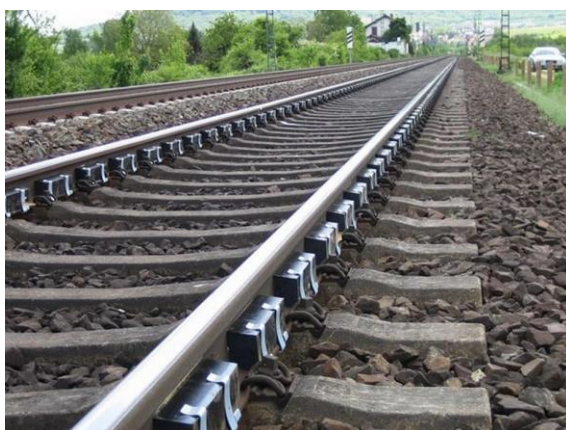
Figura 3.37. Aplicação e aspeto interno dos Rail Dumpers ( http://www.wonros.com/rail-dampers )
