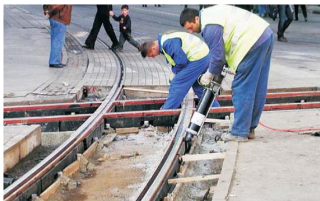
Figura 3.36. Instalação de material elástico (Lakušić & Ahac, 2012)
