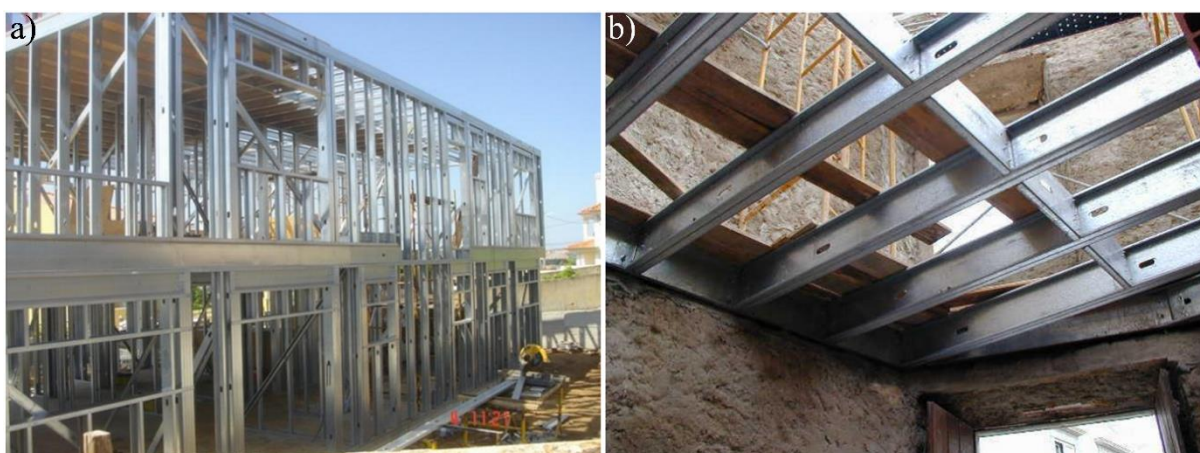
Figura 2.1 – Aplicação de perfis de aço enformado a frio na construção (Pires, 2013).
