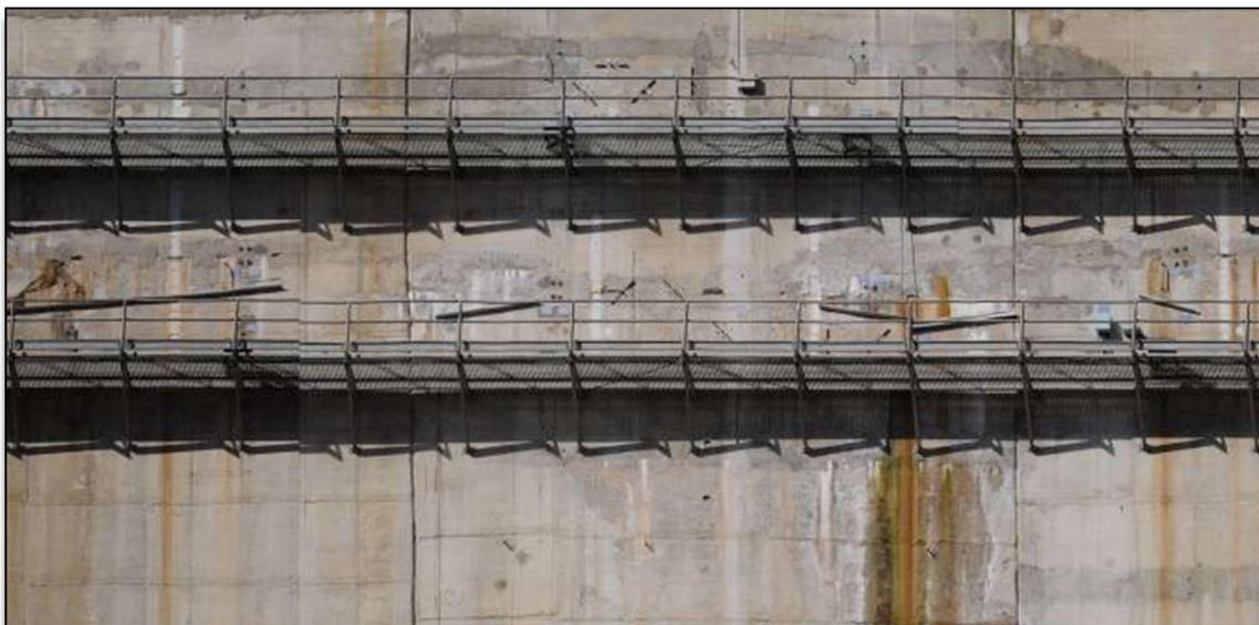
**Figura 5** – Orto-imagem de alta resolução do paramento jusante da barragem do Cabril, com uma resolução de 3 milímetros.
