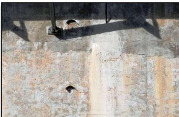
**Figura 6** – Pontos materializados no paramento jusante da barragem.
