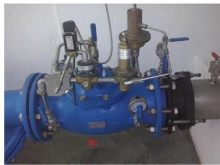
Figura 4.9 - Válvula Redutora de Pressão - (6).
