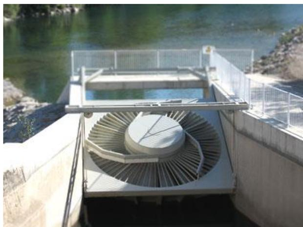
Figura 3.3: Turbina de baixa queda (VLH turbine@ 2013)
