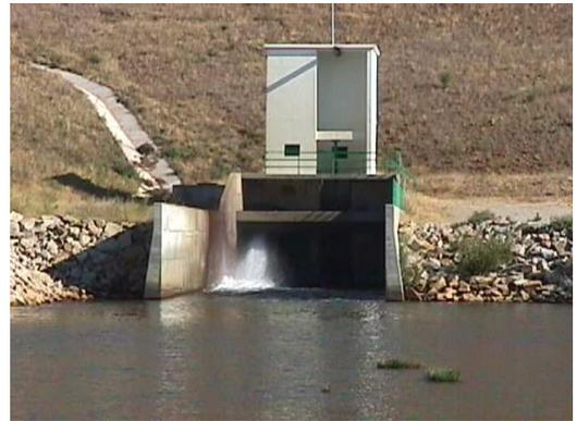
Figura 5 - Barragem do Sabugal, descarga de fundo.
