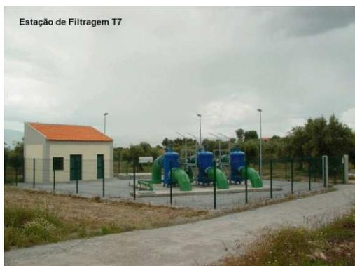
Figura 25 – Rede secundária de rega, estação de filtragem em pressão.
