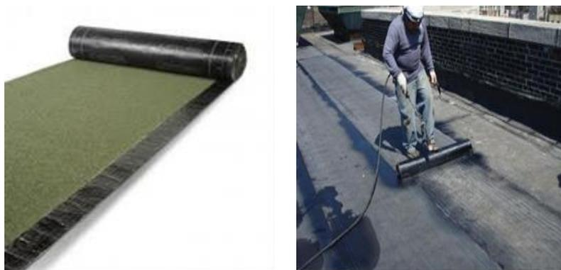
Figura 2.10 - Membrana Betuminosa para aplicação a quente
