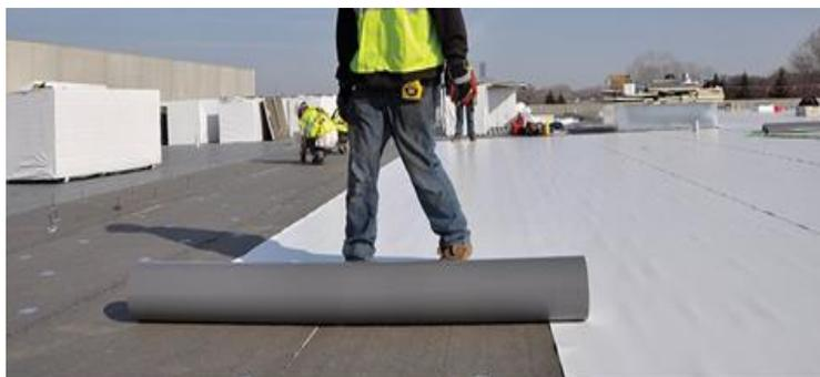
Figura 2.11 – Exemplo de membrana Single- Ply (Fonte: <http://www.archiexpo.com>)
