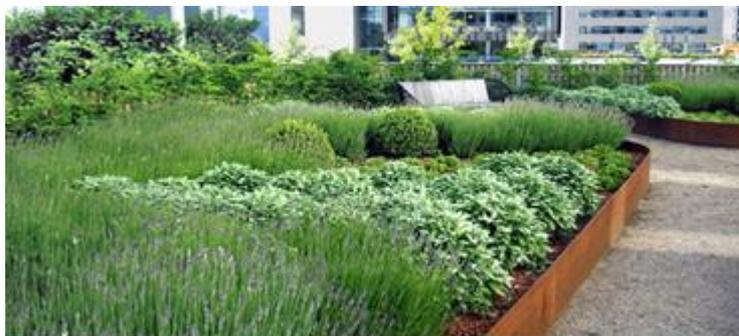
Figura 2.7 - Exemplo de uma cobertura semi-extensiva (Fonte: <http://www.greenroofs.com>)
