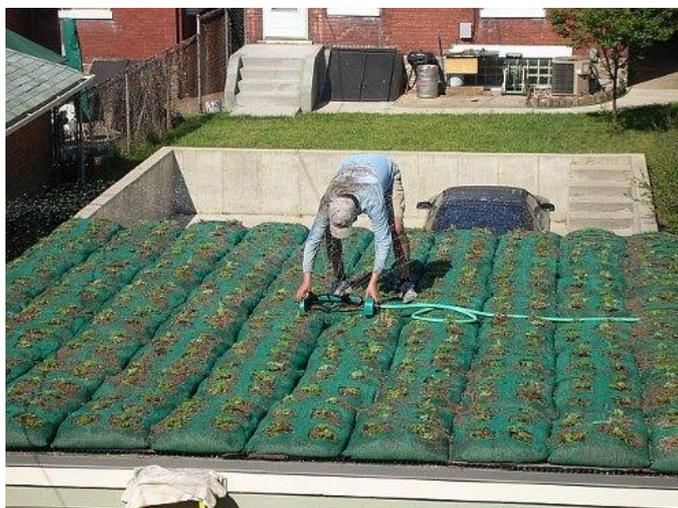
Figura 2.18 - Sistema em Saco (Fonte: <http://greenroofblocks.com>)
