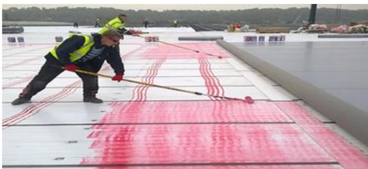
Figura 2.12 – Sistemas de Impermeabilização líquida (Fonte: <http://www.archiexpo.com>)
