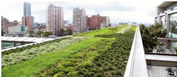
Figura 2.5 – Exemplo de uma Cobertura Extensiva ( Fonte: Zinco GreenRoof)
