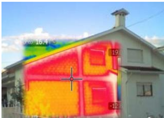
Figura 3.8- Imagem termográfica de moradia em construção tradicional durante a estação fria, Coimbra (Simões e Mateus, 2017).
