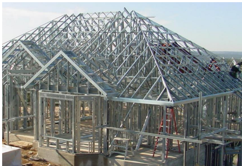
Figura 2.5 - Estrutura de uma moradia unifamiliar construída com o sistema LSF (Futureng, 2018e).
