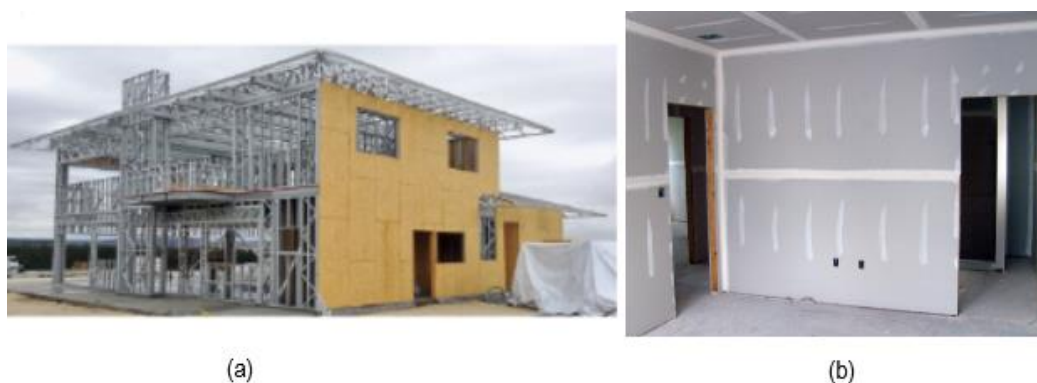
Figura 2.7 - Aplicação de placas de revestimento: (a) placas OSB no exterior; (b) placas de gesso cartonado no interior (Futureng, 2018e).
