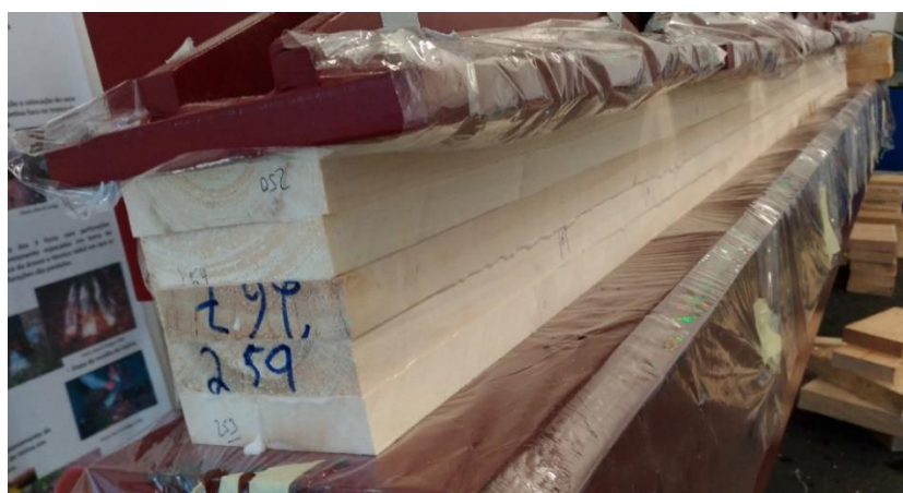
Figura 4.5 – Viga sob prensagem, colada com cola do tipo MUF
