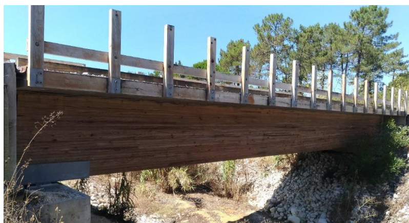
Figura 2.2 – Ponte rodoviária, solução mista madeira-betão, Quiaios
