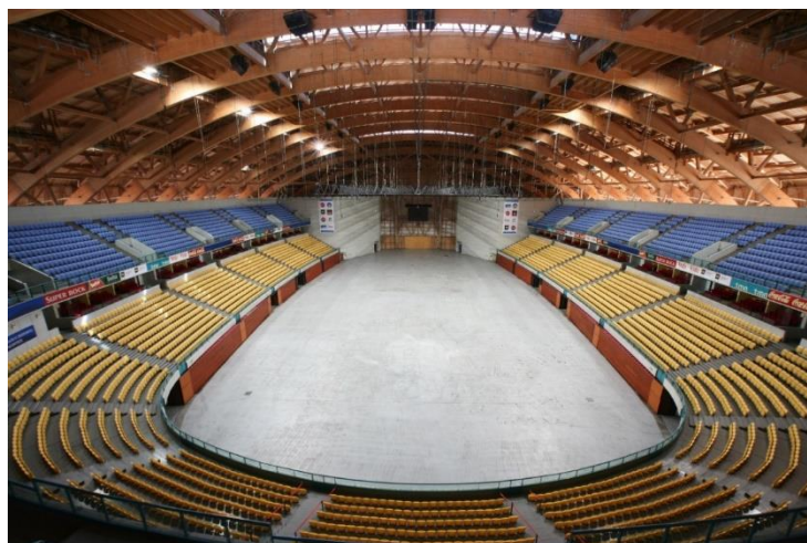
Figura 2.4 - Vista da cobertura da Altice Arena, anterior pavilhão da Utopia e Meo Arena ( http://www.nfeiras.com/meo-arena/ )
