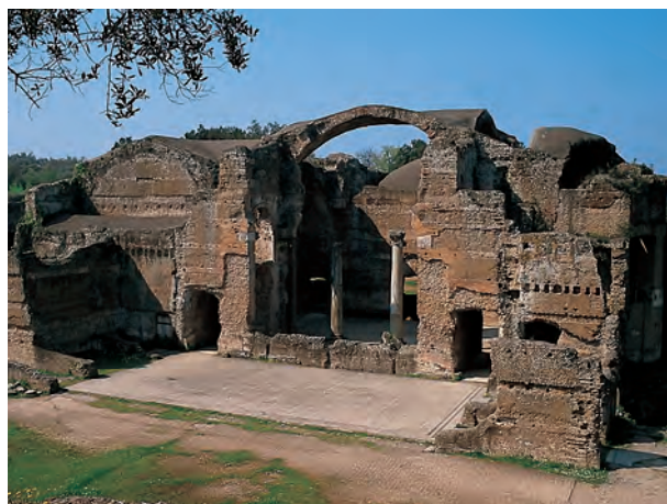
Termas da vila de Adriano, Tivoli, onde se evidencia bem a técnica do betão. © Dagli Orti.
