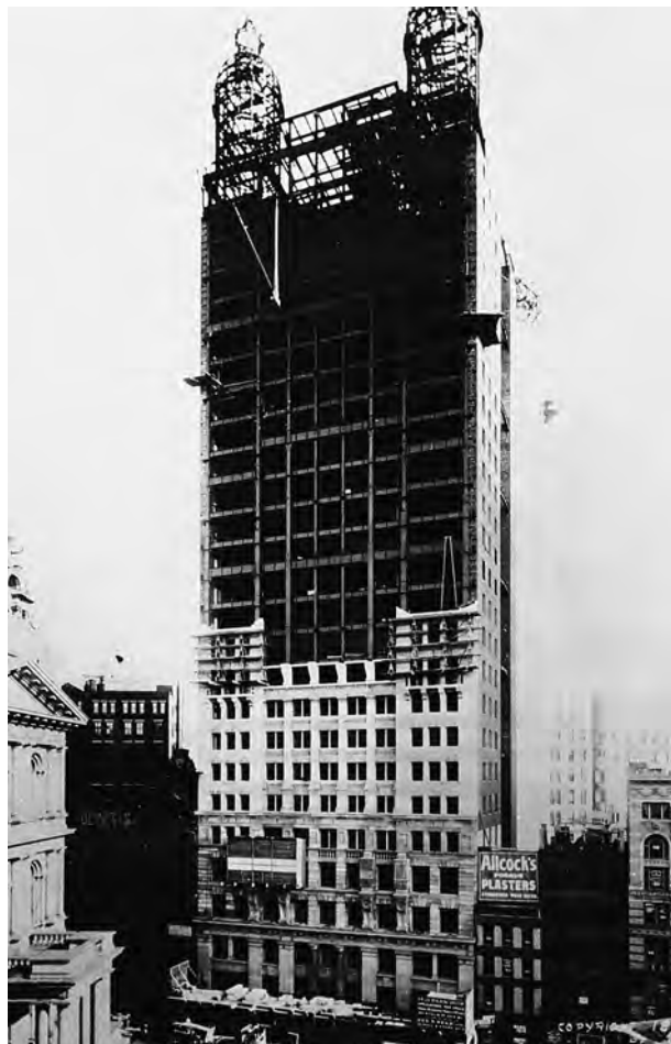
Park Row Building, em construção, 1902. Nova Iorque. © Edimedia
