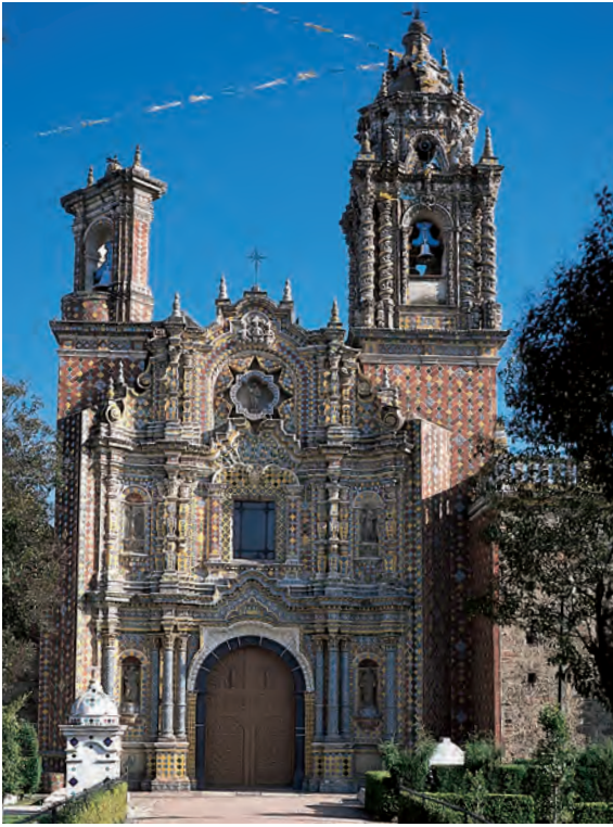
Fachada da Igreja de São Francisco, Acataptec, México. © Dagli Orti.
