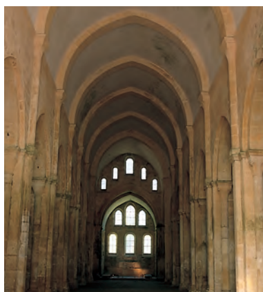
Abóbada de berço quebrado (Abadia de Fontenay). © Alain Rivière-Lecœur/TOP.
