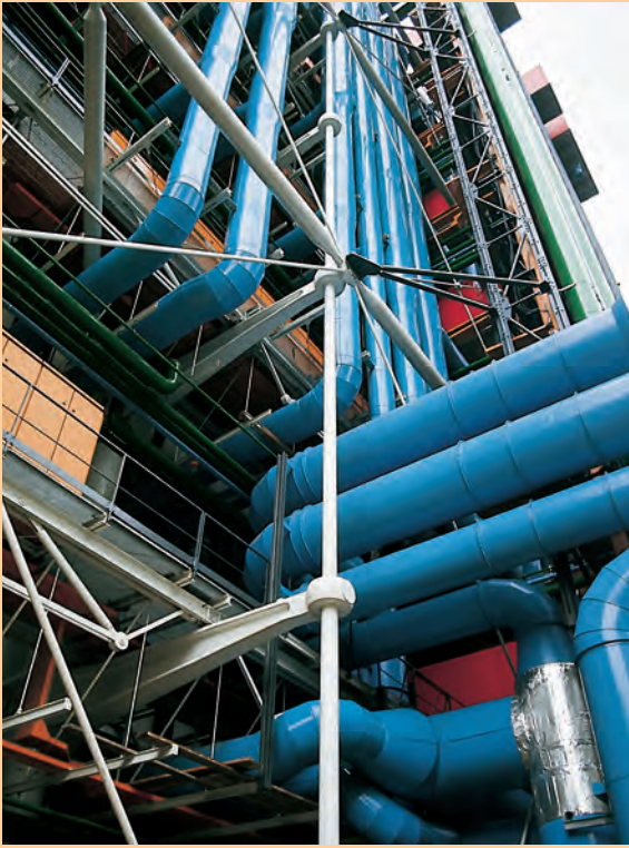
Fachada técnica ostentando os tubos aparentes. © Remy Poinot/Pix.
