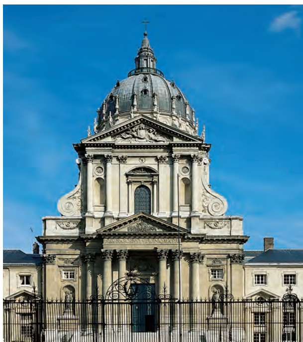
Fachada da Igreja de Val-de-Grâce, Paris. © Deneux/Agence TOP.
