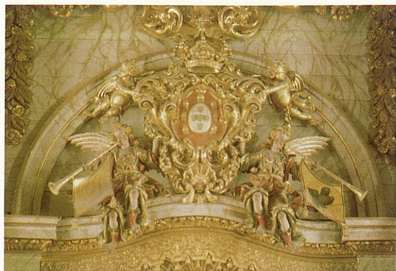
Biblioteca da Universidade de Coimbra, detalhe
