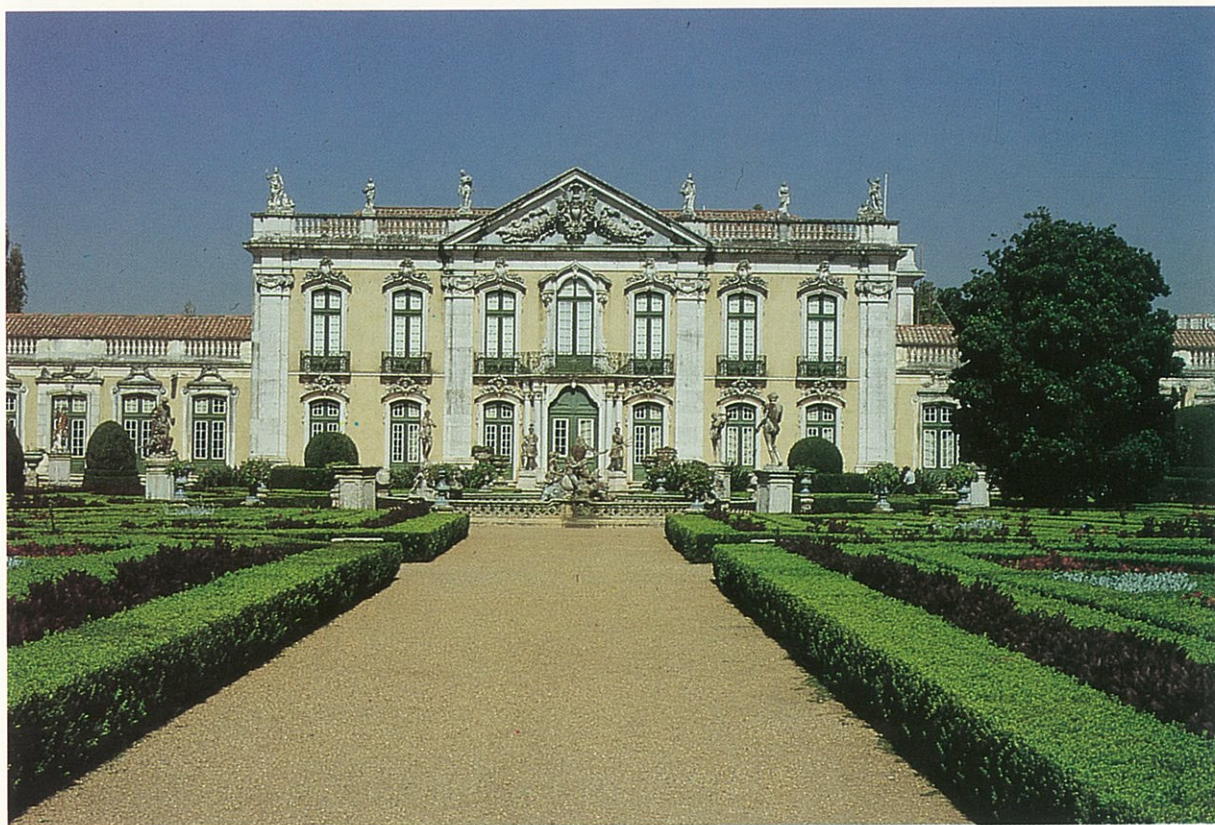
Palácio de Queluz. Fachada de Cerimónia
