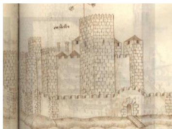
Vista da banda do leste (E), fl.31.
