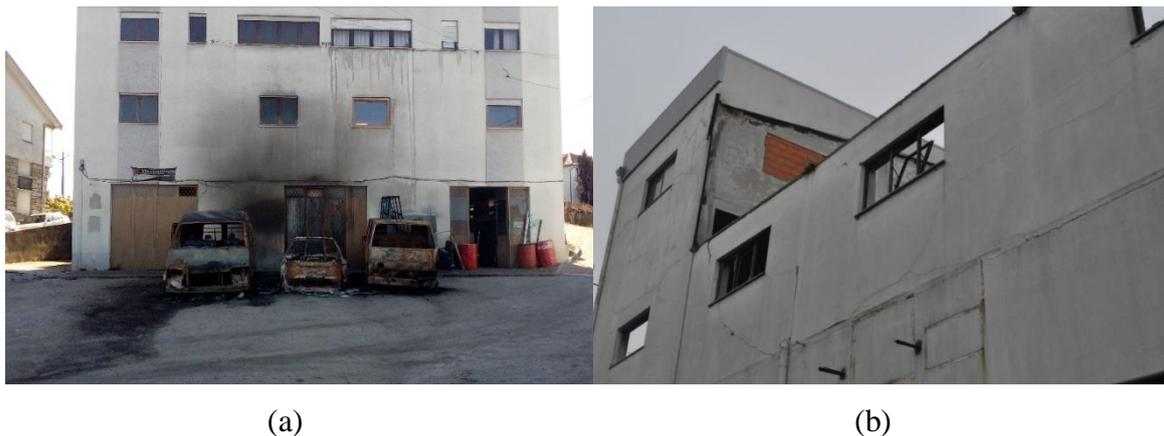
**Figura 4.12** Origem de início de ignição reportado (a) através da porta de entrada da empresa; (b) através da janela.
