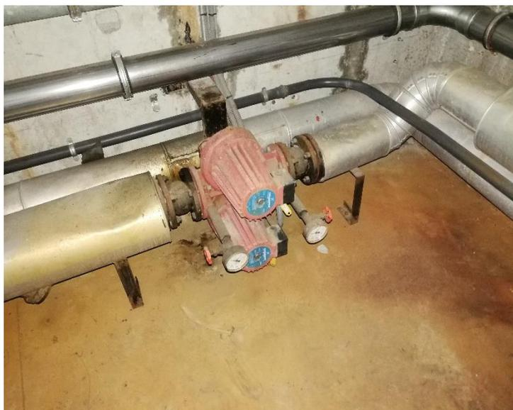
Figura C.3 - Bomba de circulação dos Chillers.
