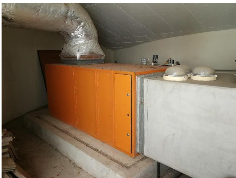
Figura C.7 – Exemplo de uma UTA instalada.
