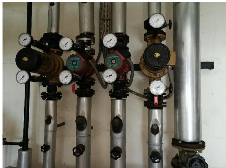
Figura C.6 - Bombas de circulação de água quente das UTAs.
