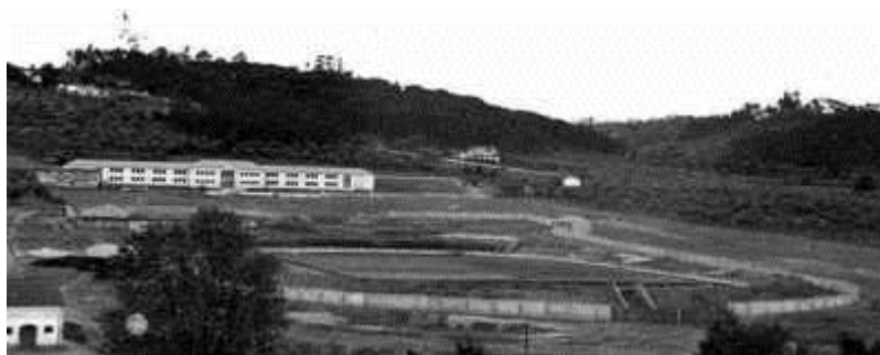
Figura 1 – Antigas instalações da Escola Secundária Infanta D. Maria.
