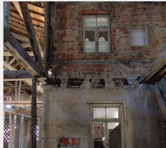
16. Transição da alvenaria em pedra para alvenaria de tijolo cerâmico entre os 3º e 4º pisos.
