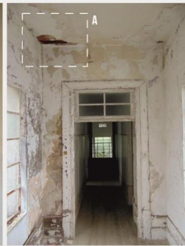
13. Corredor de ligação entre ala da sala de espetáculos e corpo principal no nível do 3º piso. No teto, laje aligeirada; no piso, régulas de madeira fixadas em estrutura de madeira.
