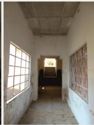
12. Corredor de ligação entre ala da sala de espetáculos e corpo principal no nível do 2º piso. No teto, estrutura de madeira do pavimento superior com placas de madeira como material de acabamento e, no piso, taco de madeira assentado sobre contrapiso de betão.
