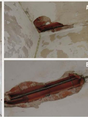
A. Detalhe da laje aligeirada armada de tijolo cerâmico furado.
