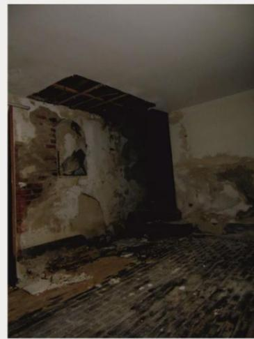
11. Arrecadação abaixo do palco da sala de espetáculos: piso em taco de madeira, alvenaria em tijolo e estrutura do pavimento do palco em madeira revestido em placas de gesso.
