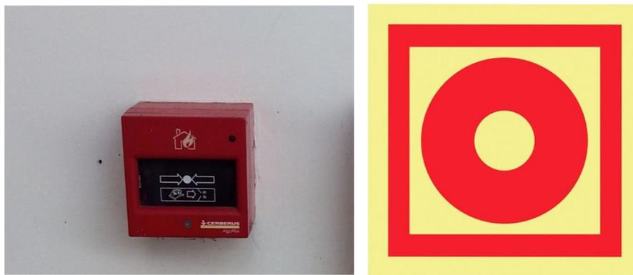
Figura 9. Botão de alarme (exemplo e simbologia usada na planta de emergência).
