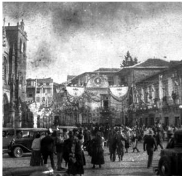
Fig.320 – Casa da Viscondessa de Guiães (do lado direito da foto), em frente à fachada da Sé. Cerca de 1933. Fotógrafo, Filipe Borges Júnior (1892-1982) 363 .
