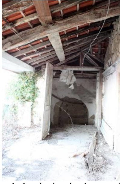
Fig.592 - Porta no terraço / varanda do primeiro piso de acesso à capela da casa. Parte posterior da Casa do Alvão. Alvelos, Lamego. Fotografia da autora.
