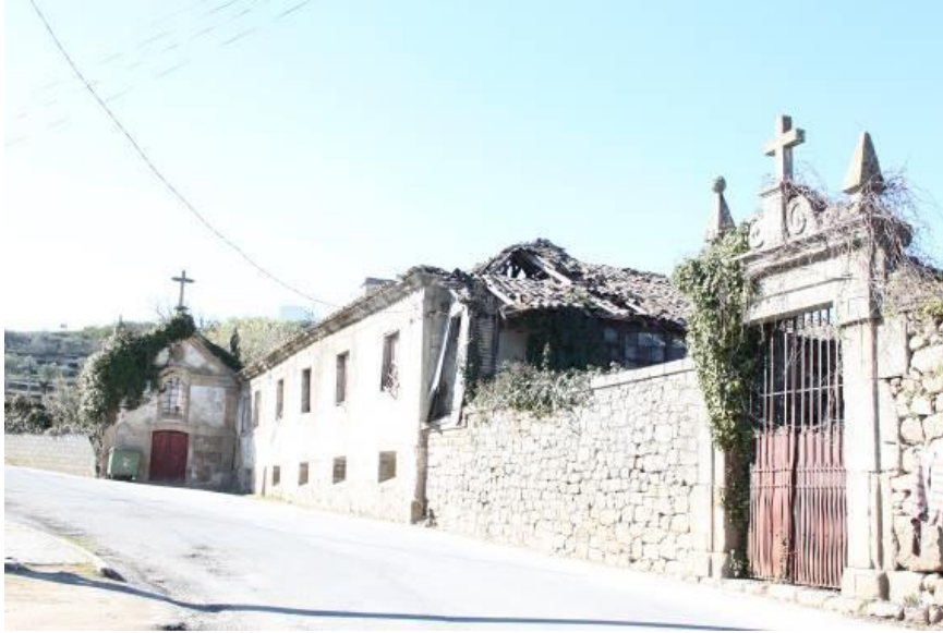
Fig.556 - Fachada principal da casa da Quinta das Brolhas, com capela e portal de entrada virados para a via pública 626 . Alvelos, Lamego. Fotografia da autora.
