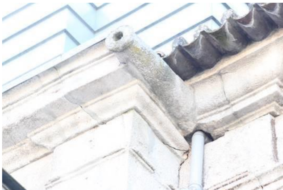
Fig.345 – Gárgula não decorativa projetada na parte superior do edifício, no beirado do telhado para escoamento de águas pluviais 384 . 2013, fotografia da autora.
