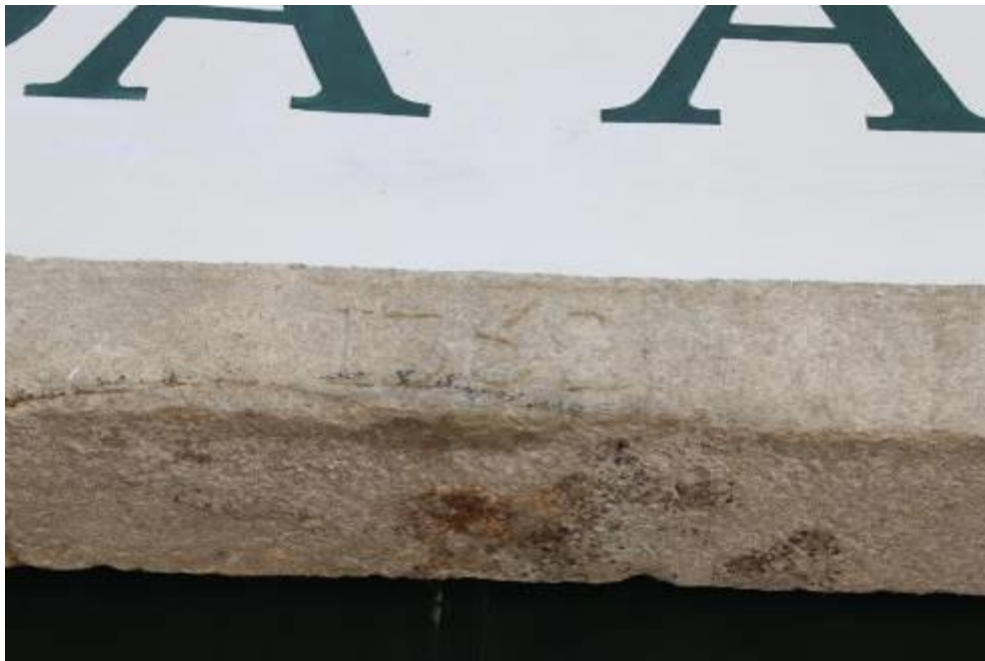
Fig.700 - Inscrição “1732 (?) ou “1752” (?) na pedra de granito da parte superior da porta, no edifício com inscrição “Casa da Azenha”. Fotografia da autora.
