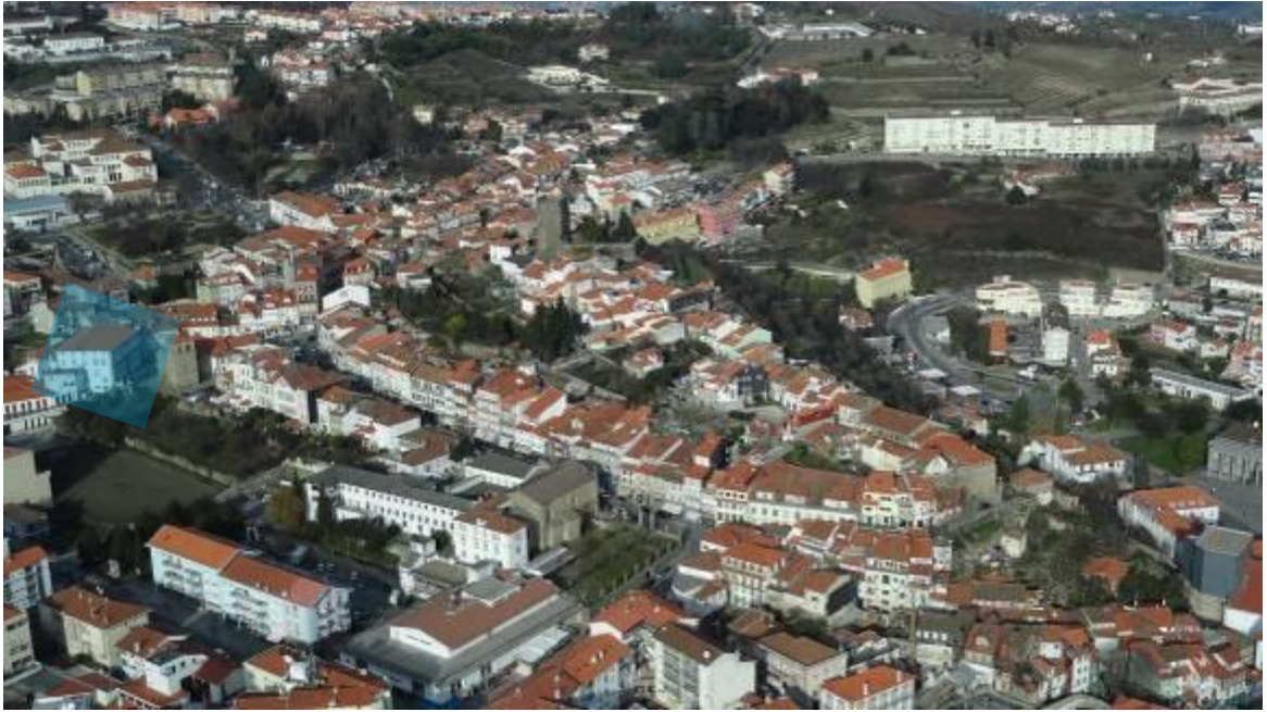
Fig.38 – Vista aérea do enquadramento da casa dos Sousa Maldonado (atual Paço Episcopal), na cidade 48 .
