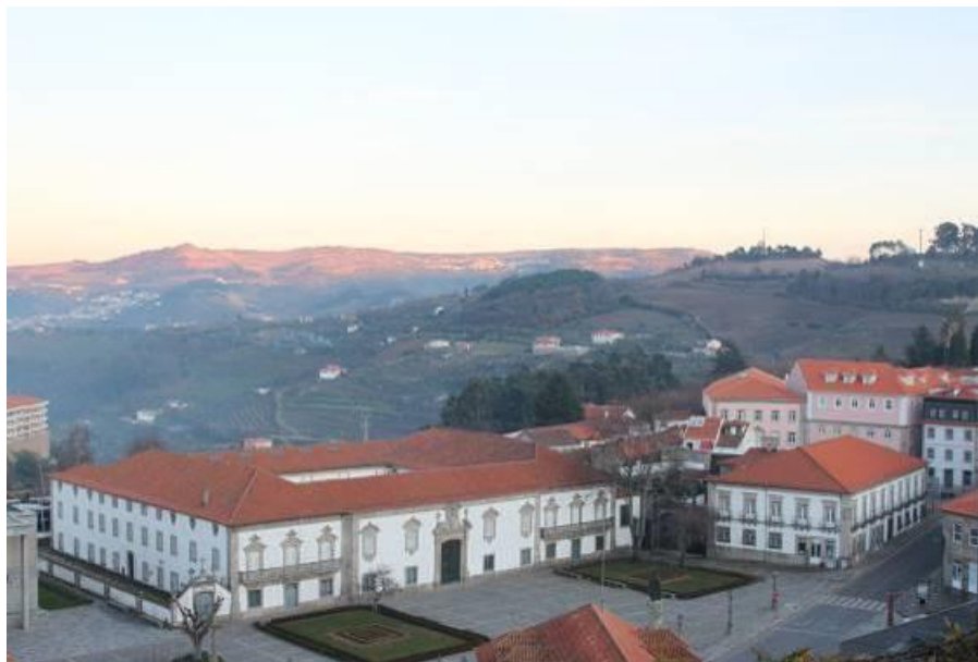
Fig.235 – Vista aérea da casa do Deão do cabido D. António Freire Gameiro de Sousa (séc. XVIII) /Colégio da Imaculada Conceição (séc. XXI), nas traseiras da casa dos Mores (em 1.º plano). Fotografia da autora.
