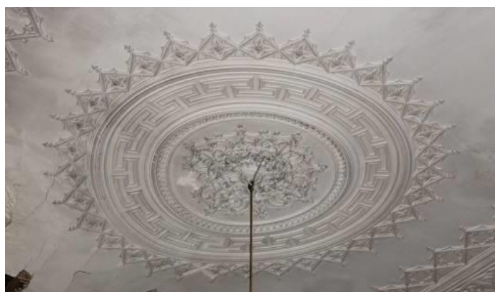
Fig.221 - Painel central circular, com decoração estucada vegetalista e geométrica, na sala do piso nobre, da casa das Brolhas. Centro Histórico de Lamego (Sé). Fotografia da autora.
