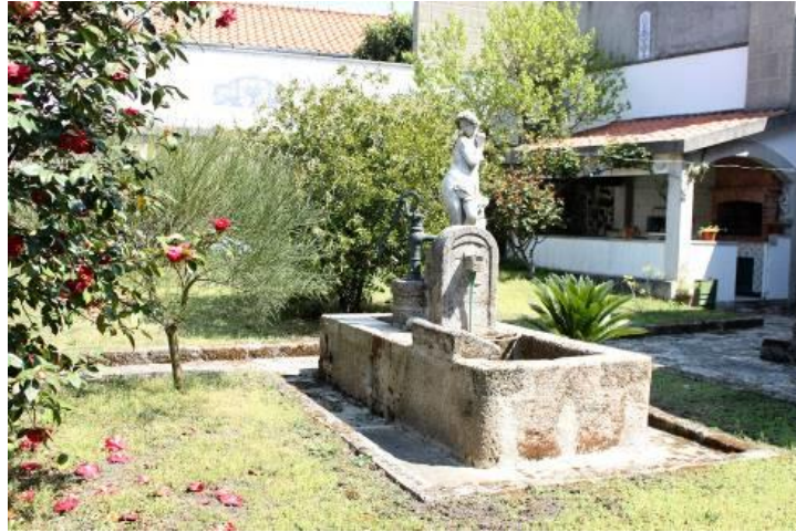
Fig.304 - Estrutura retangular de tanque de lavar, com bomba metálica de tirar água de uma cisterna anexa 335 . Jardim da Casa dos Mores. Fotografia da autora.
