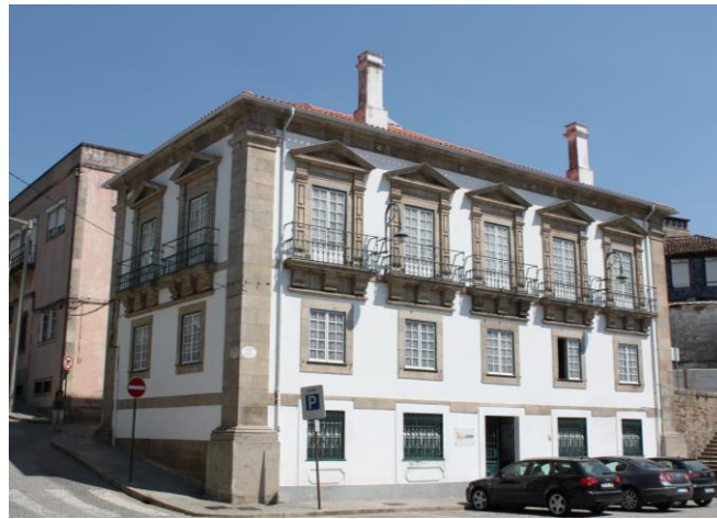
Fig.148 - Fachada lateral e traseira da casa do Assento ou Solar dos Padilhas. Fotografia da autora.
