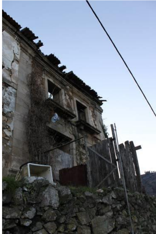
Fig.1052 – Corpo da fachada principal da casa de Angorês. Fotografia da autora.
