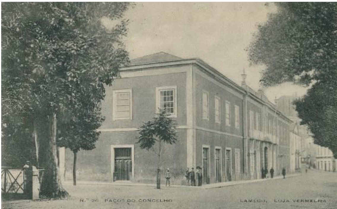
Fig.103 - Paços do concelho, igreja da Nossa Senhora da Graça com pórtico renascentista e Solar Pinheiro de Aragão (à direita de quem olha para a fotografia) 129 . S/d.
