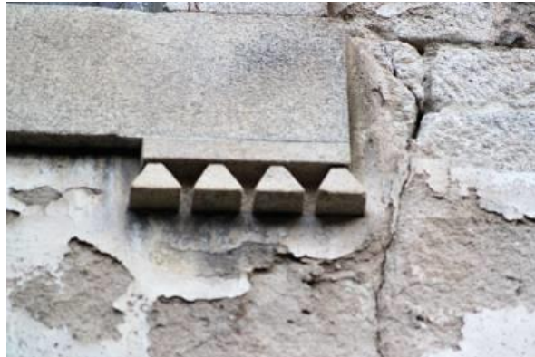
Fig.1028 - Sequência de pormenor decorativo em forma de quatro triângulos, de remate da parte inferior das janelas do primeiro piso, da fachada principal 1046 . Casa do Conde de Samodães. Fotografia da autora.
