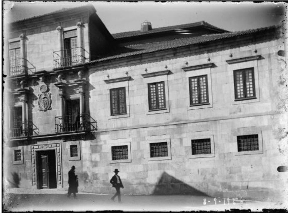
Fig.387 - Fachada principal da casa do Visconde de Arneirós ou casa dos Pinheiros. Fundo de Fotografia Conde de Alpendurada, [Solar da Casa dos Pinheiro ou do Visconde de Arneiro, Lamego], PT/CPF/ALP/0001/000024, Imagem cedida pelo Centro Português de Fotografia 438 . 1926-09-08.
