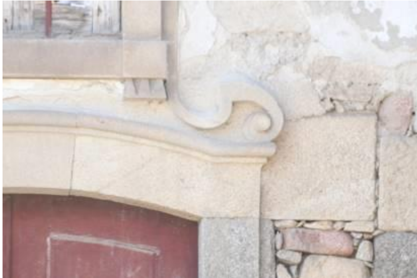
Fig.560 - Ornatos laterais entre a porta e a janela, na fachada da capela da Quinta das Brolhas 628 . Simetria com o outro lado do intervalo porta/janela. Alvelos, Lamego. Fotografia da autora.
