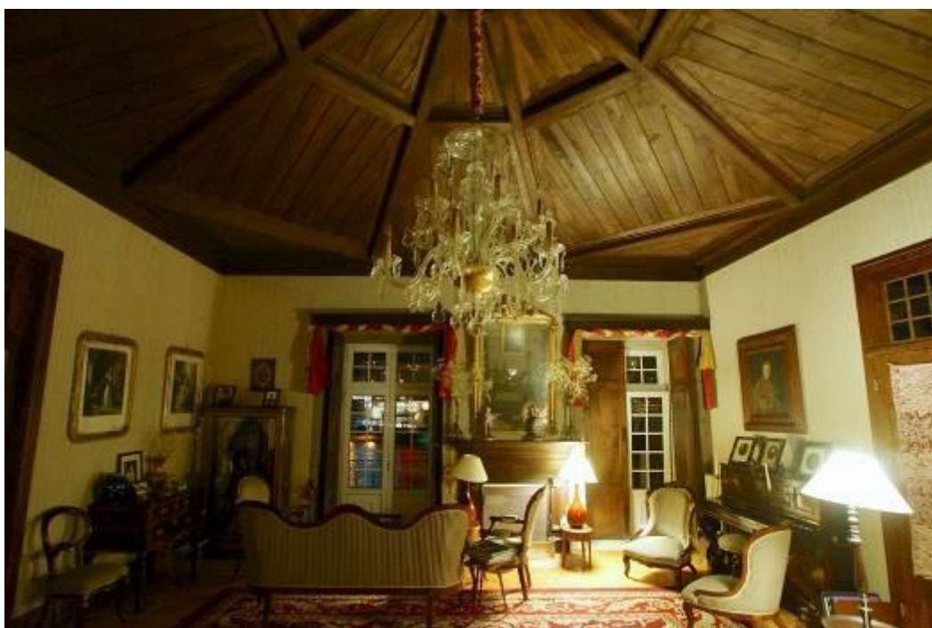
Fig.872 – Salão da casa dos Varais, com teto em masseira 889 . 5 de agosto de 2015. S/a.
