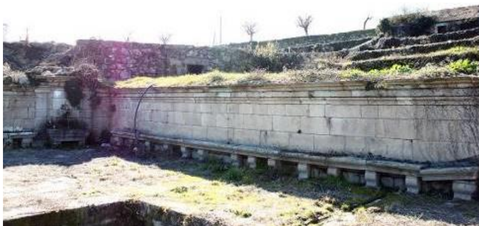
Fig.597 - Estrutura de fonte inserida em muros, com bancos corridos em granito e tanque de água. Casa do Alvão. Alvelos, Lamego. Fotografia da autora.
