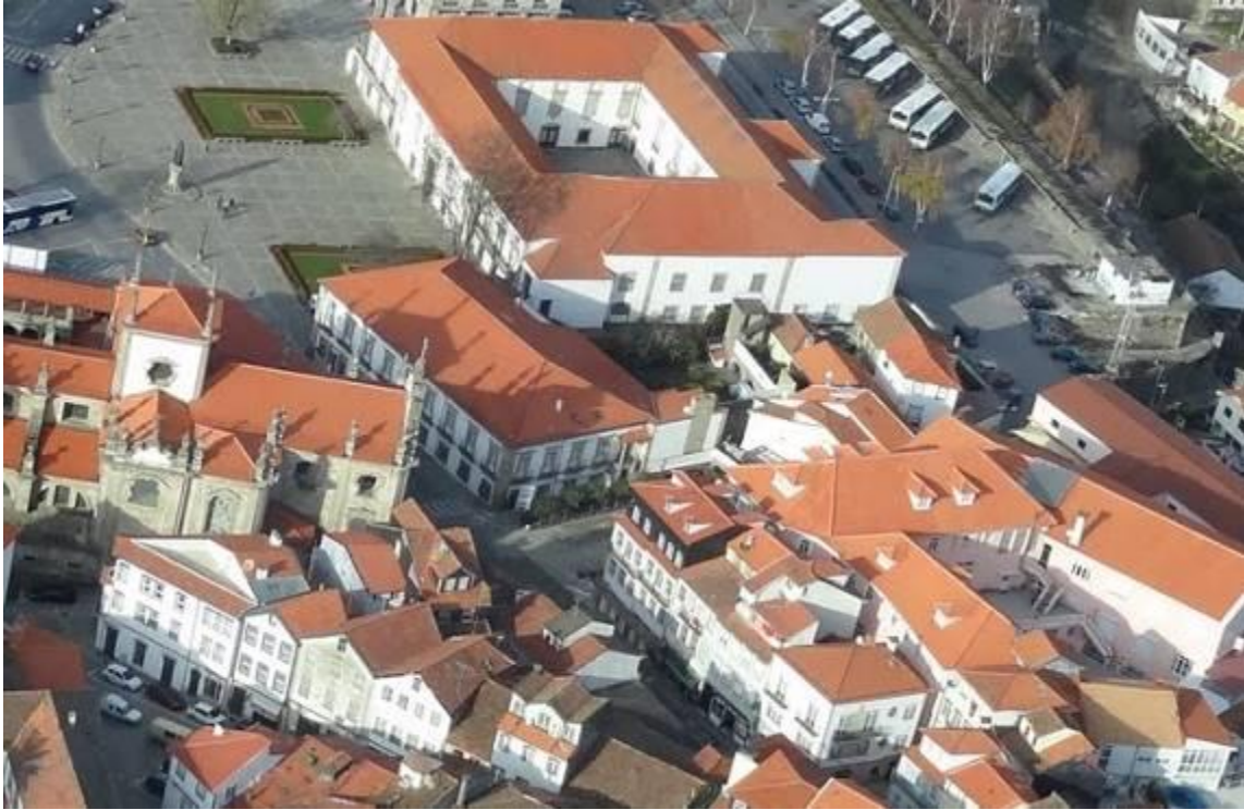
Fig.284 – Vista aérea do enquadramento da casa dos Mores junto à Sé 329 .
