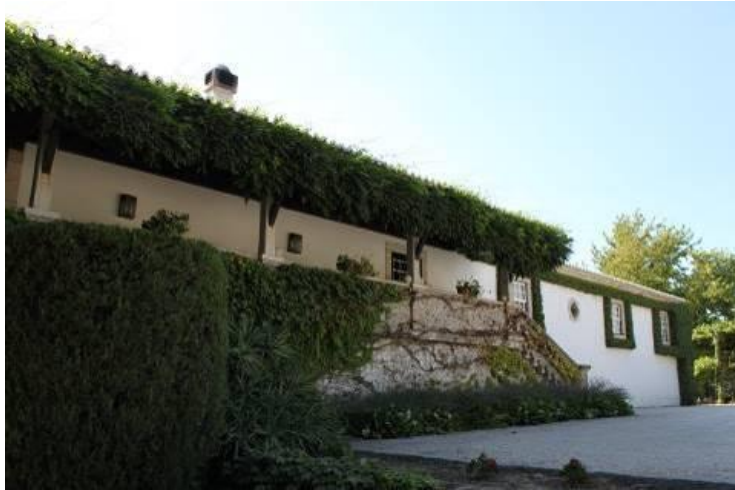
Fig.735 – Fachada Este da casa principal (residência) da Quinta da Pacheca. Fotografia da autora.
