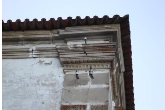
Fig.1057 – Ornatos decorativos no remate superior (junto ao telhado), da pilastra da fachada lateral da casa de Angorês. Fotografia da autora.
