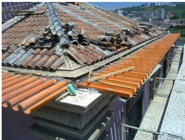
Fig.865 – Vista das obras no telhado da casa dos Varais, em 2010 884 .
