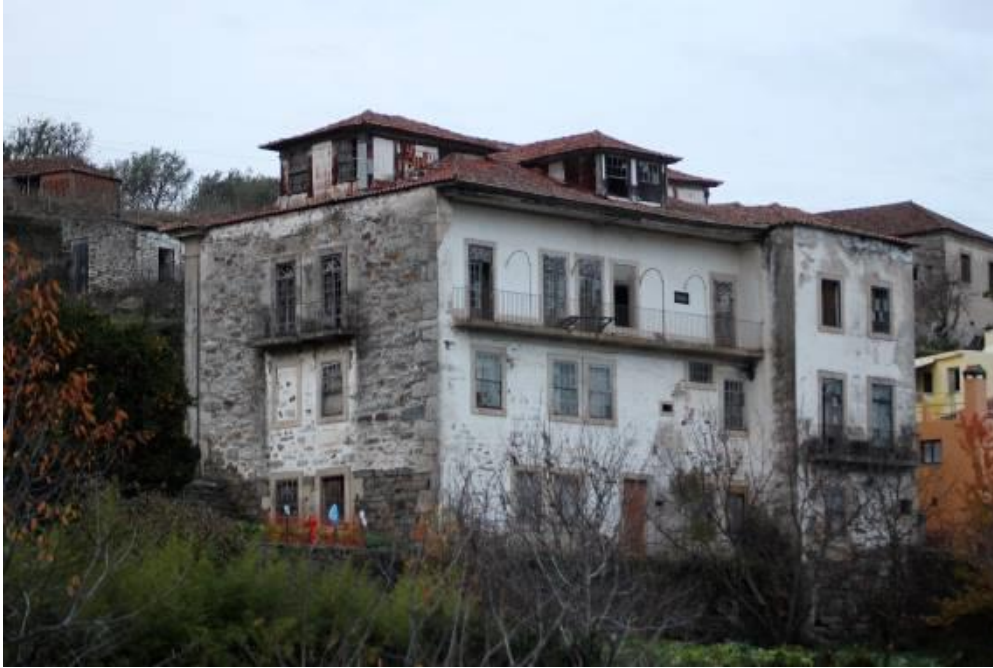
Fig.1031 - Fachada lateral direita e fachada posterior da casa do Conde de Samodães. Fotografia da autora.
