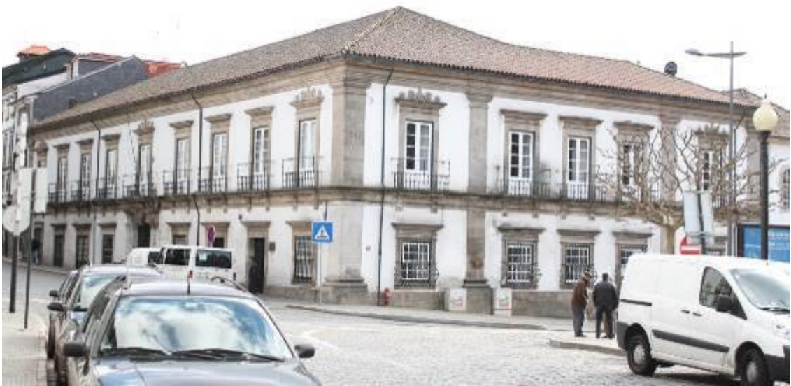
Fig.114 - Fachada principal e lateral do Solar Pinheiro de Aragão. Fotografia da autora.
