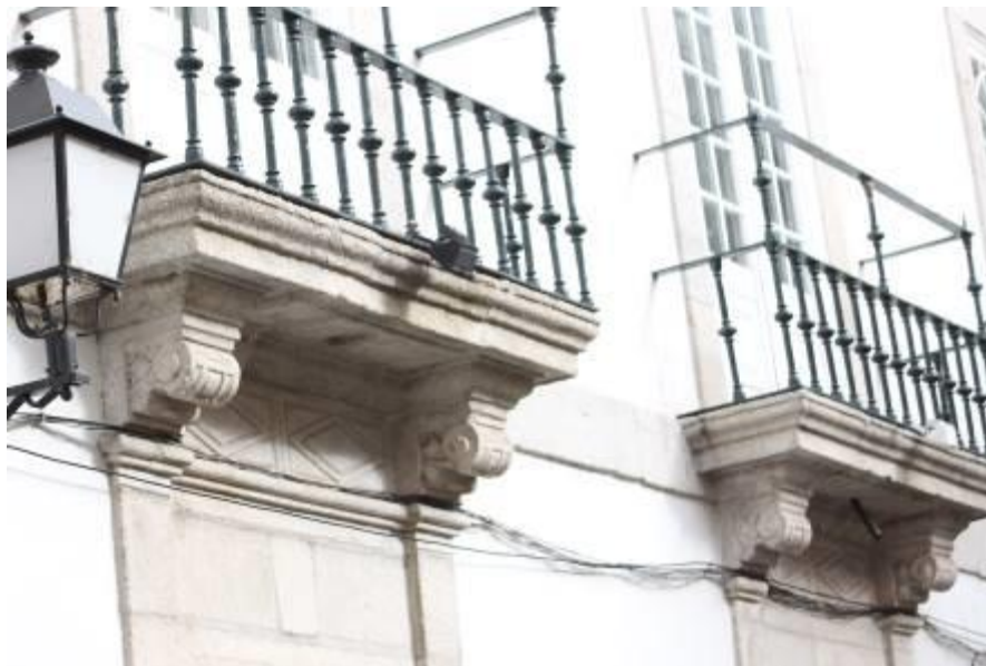
Fig.73 - Aspeto decorativo com motivos geométricos, da parte inferior de suporte das varandas do 1.º Piso, ao nível da transição do rés do chão para o piso nobre. Fotografia da autora.
