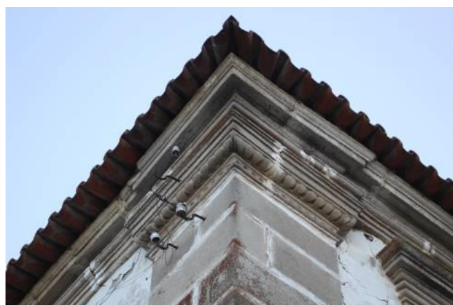
Fig.1056 – Ornatos decorativos no remate superior (junto ao telhado), das duas pilastras, a da fachada principal e a da fachada lateral da casa de Angorês 1066 . Fotografia da autora.
