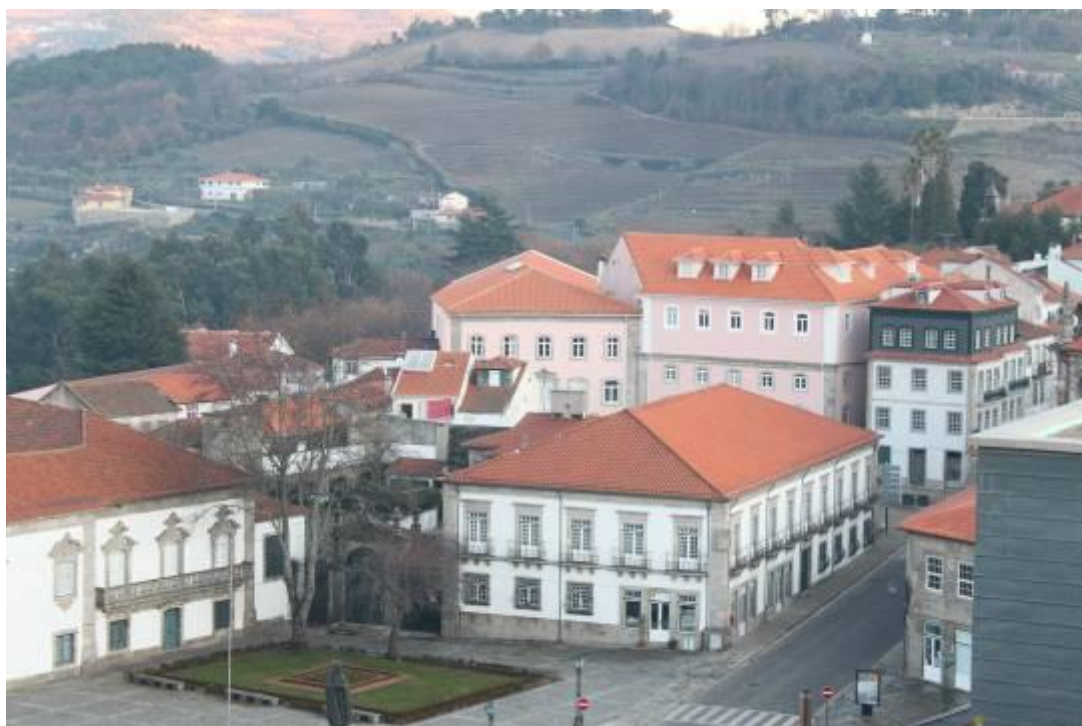
Fig.236 – Vista da casa do Deão do cabido D. António Freire Gameiro de Sousa (séc. XVIII) /Colégio da Imaculada Conceição (séc. XXI), nas traseiras da Casa dos Mores (em 1.º plano). Fotografia da autora.
