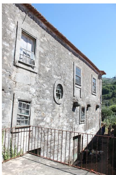
Fig.952 - Fachada posterior da Casa do Montenegro 1 989 . Fotografia da autora.
