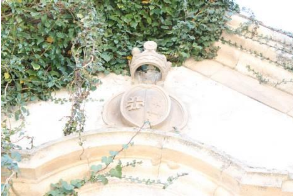
Fig.564 - Enquadramento da pedra de armas na fachada da capela da Quinta das Brolhas, junto ao telhado. Alvelos, Lamego. Fotografia da autora.
