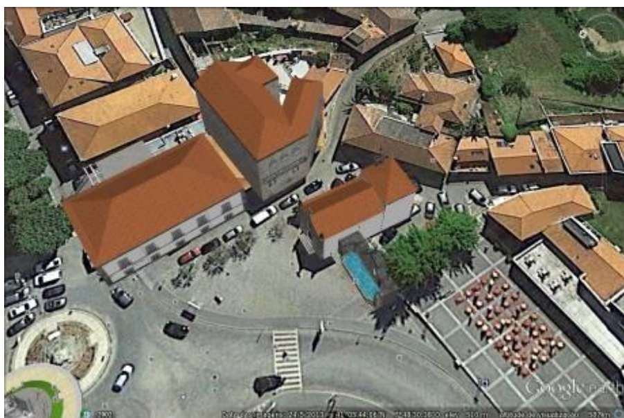
Fig.405 - Vista aérea da casa do Espírito Santo 1; casa do Espírito Santo 2 (patronato de S. José); capela e fonte do Espírito Santo. © Google Earth 449 .
