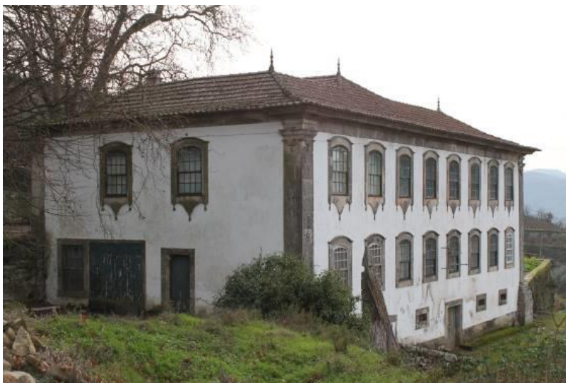
Fig.937 - Fachada posterior virada para o rio Douro, e fachada lateral da casa da Quinta do Estremadouro 976 . Fotografia da autora.
