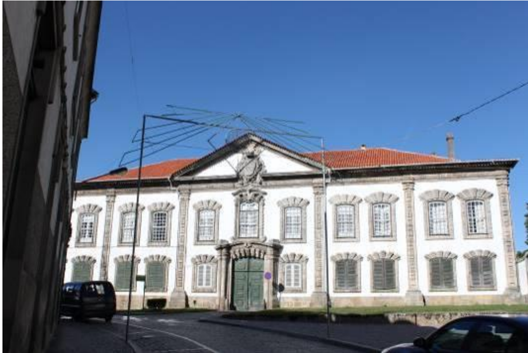
Fig.206 – Fachada principal orientada a Sudoeste com elementos em cantaria, composta por cinco panos com janelas e rematada com frontão triangular onde se insere a pedra de armas. Fotografia da autora.
