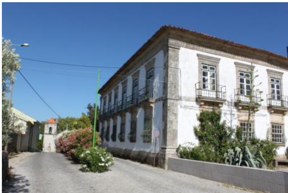
Fig.651 – Fachada lateral 713 , e parte da principal da casa da Corredoura. Fotografia da autora.
