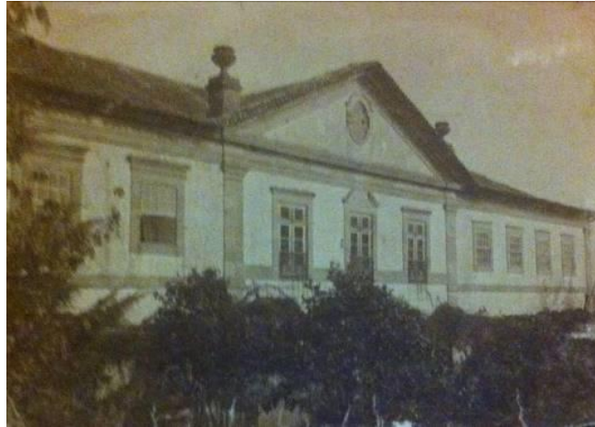
Fig.632. – Fachada lateral e jardim anexo da Casa da Corredoura 698 . S/d. S/a.
