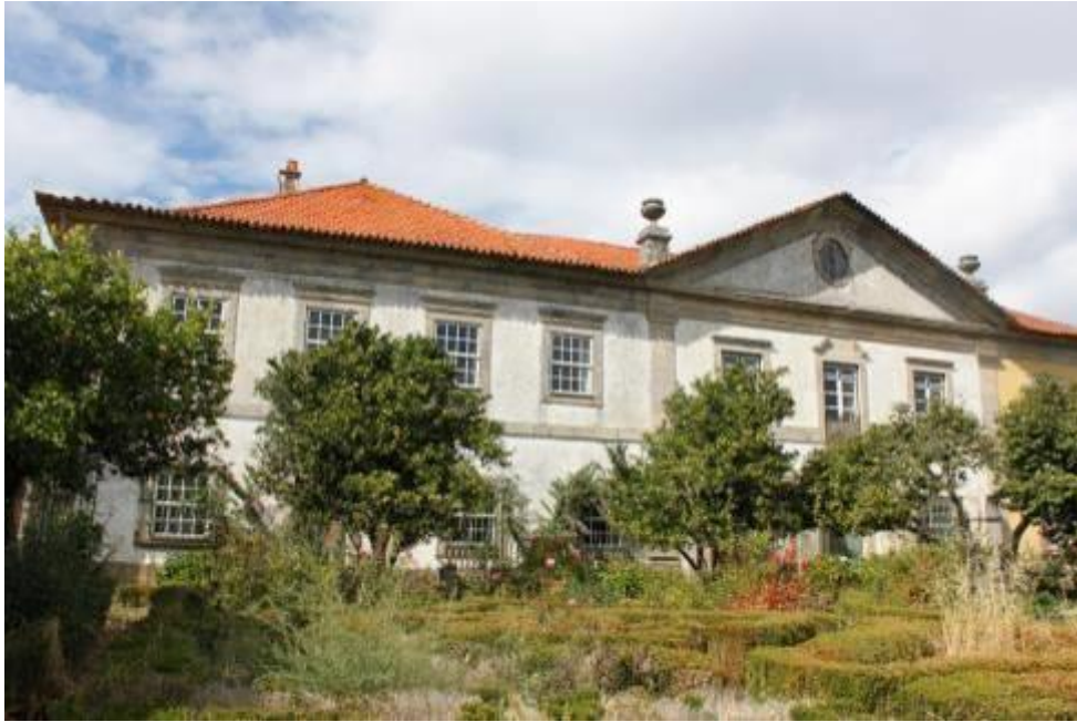
Fig.660 - Fachada lateral da casa da Corredoura e jardim com canteiros de buxo, árvores e lago. Fotografia da autora.
