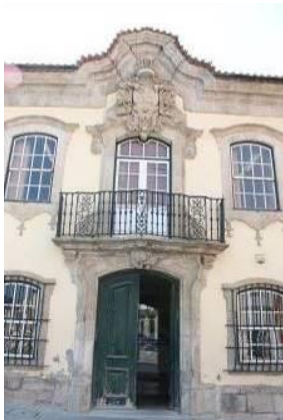
Fig.475 - Eixo visual vertical porta/varanda/pedra de armas (fachada nascente). Casa dos Serpas ou casa de Santa Cruz (Ministério da Justiça, serviços de Registos Civil e Predial, Notariado e Tribunal de Trabalho). Fotografia da autora.
