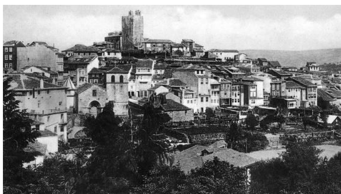
Fig.31 - Vista parcial. Casa dos Sousa Maldonado (atual Paço Episcopal, extremo esquerdo da imagem) e jardim da casa. Igreja de Almacave, castelo, bairro do castelo. Lamego 41 . S/d. S/a.
