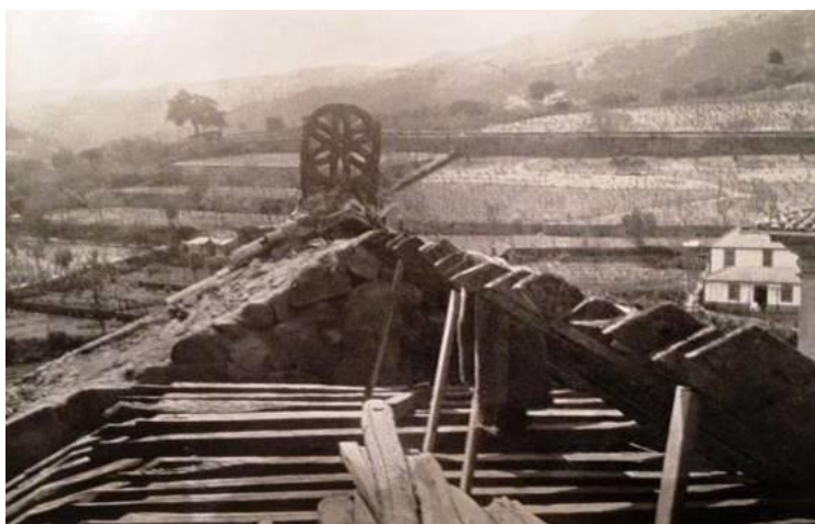
Fig.32 - Vista parcial a partir do telhado da Igreja de Almacave. Casa dos Sousa Maldonado (atual Paço Episcopal, extremo direito da imagem) 42 . Lamego. S /d. S/a.
