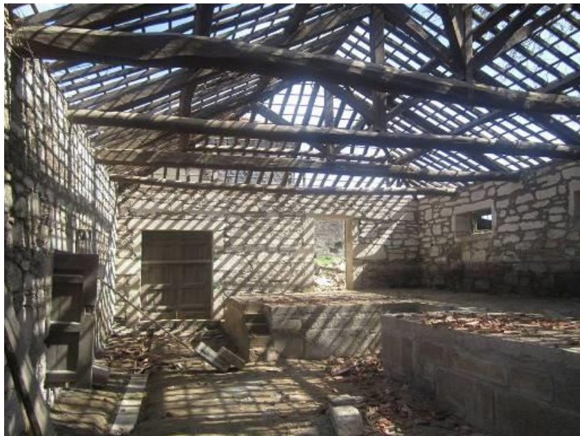
Fig.942 - Obras de requalificação da antiga adega da Quinta do Estremadouro, para a adega “Aneto Wines”. 23 de junho de 2013 981 .
