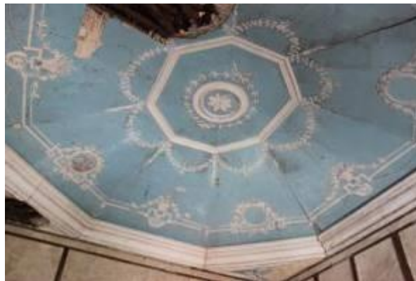
Fig.658 - Teto em estuque azul e branco com motivos vegetalistas, de um aposento da casa da Corredoura, 1.º piso 716 . Fotografia da autora.
