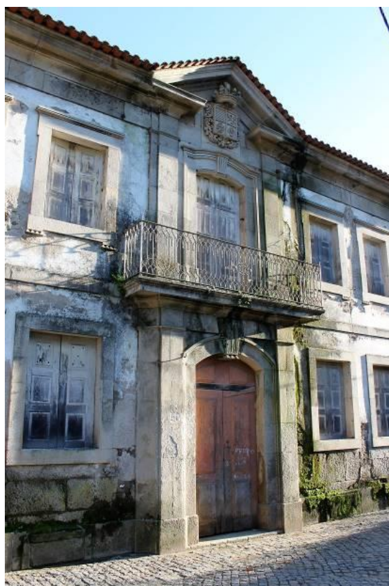
Fig.1026 - Fachada principal. Aspeto do alinhamento da porta do rés do chão com a porta da varanda do primeiro piso e com a pedra de armas do frontão. Fotografia da autora.
