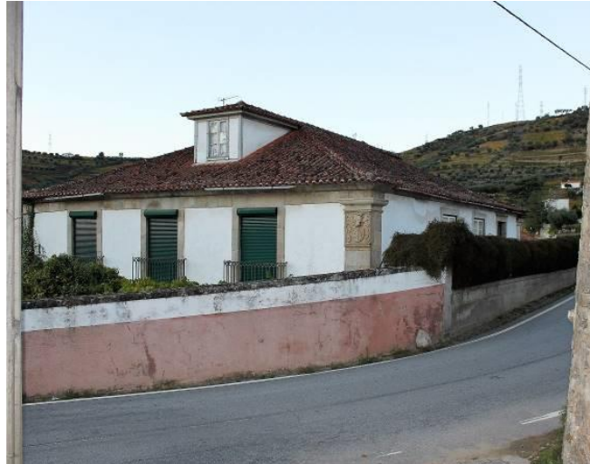
Fig.1094 - Fachada lateral e principal da casa da Quinta do Cabo 1088 . Fotografia da autora.
