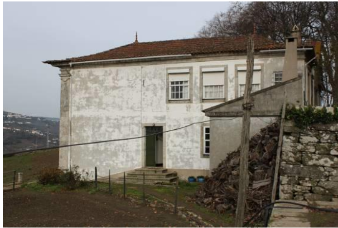
Fig.935 - Fachada lateral da casa da Quinta do Estremadouro 974 . Fotografia da autora.
