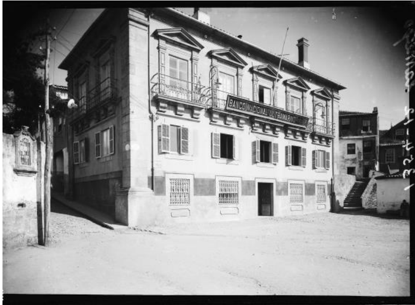
Fig.137 - Casa do Assento ou Solar dos Padilhas, como filial do BNU Lamego. Fundo de Fotografia Alvão, Casa do Assento ou Solar dos Padilhas, Lamego, PT/CPF/ALV/004905, Imagem cedida pelo Centro Português de Fotografia 168 .
