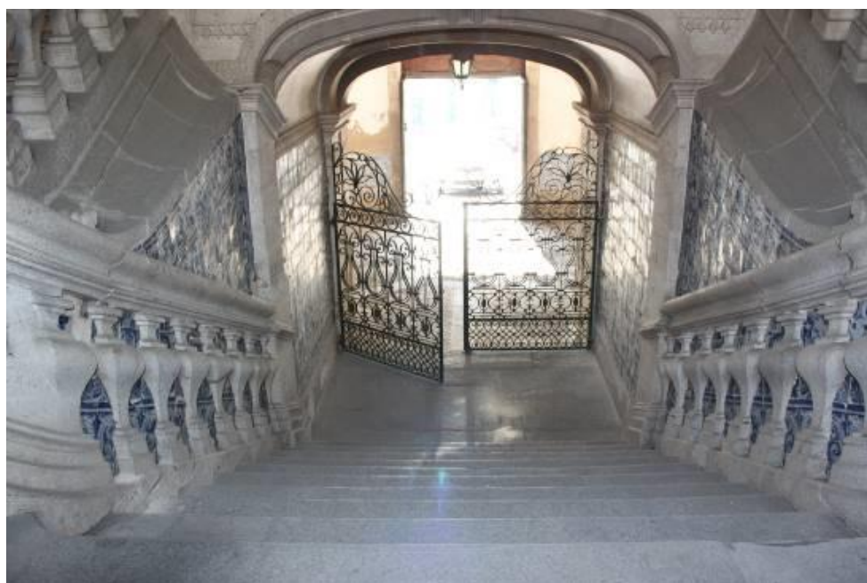
Fig.213 – Escadaria principal em pedra de dois lanços de acesso ao piso nobre com rodapé de azulejos do século XVIII. Fotografia da autora.
