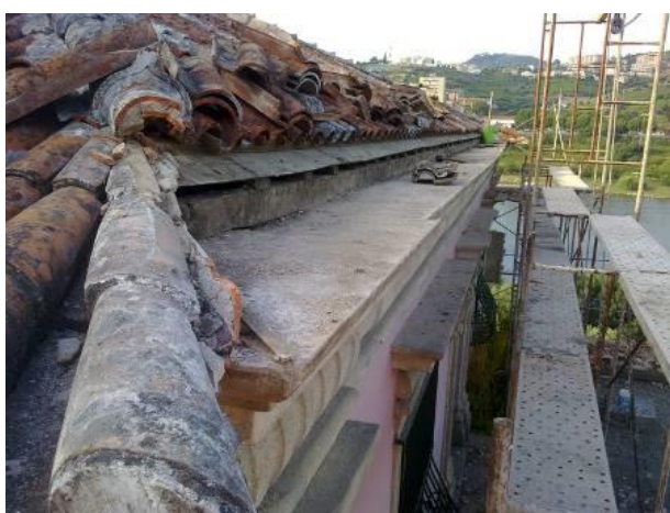
Fig.859 – Vista das obras no telhado da casa dos Varais, em 2010 878 .
