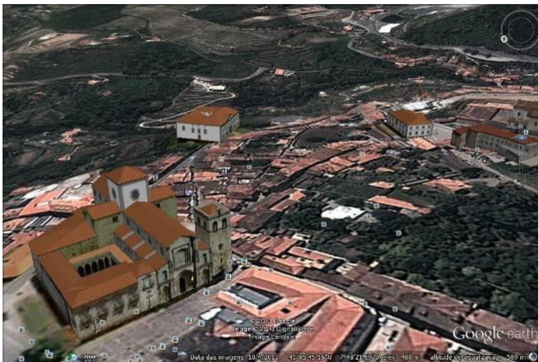
Fig.233 - Enquadramento da casa do Deão do cabido D. António Freire Gameiro de Sousa/ do colégio da Imaculada Conceição (séc. XXI), na freguesia da Sé, com edifícios a 3D: Sé; casa das Brolhas; casa dos Vilhenas (sede da Santa Casa da Misericórdia de Lamego); casa dos Serpas (Tribunal do Trabalho de Lamego); igreja e convento de Santa Cruz; igreja do Desterro. © 2013 Google. Image © 2013 GeoEye.
