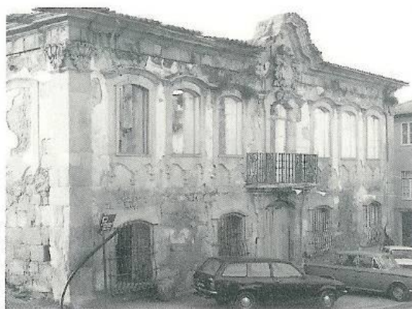
Fig.469 - Fachada principal (fachada Nascente) da casa dos Serpas ou casa de Santa Cruz em ruínas 520 .
