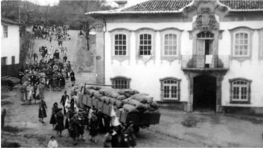
Fig.462 - Fachada Nascente da casa dos Serpas ou casa de Santa Cruz 517 . S/d; S/a.
