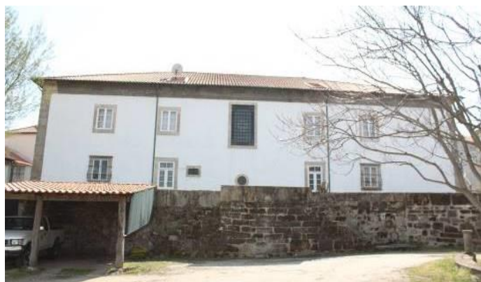
Fig.504 - Fachada posterior da casa dos Pereira Coutinho / casa dos Vilhenas (sede da Santa Casa de Misericórdia). Fotografia da autora.
