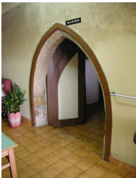
Fig.356 – Porta gótica antes do início dos trabalhos arqueológicos 405 , integrada na sondagem 01, em 2002.
