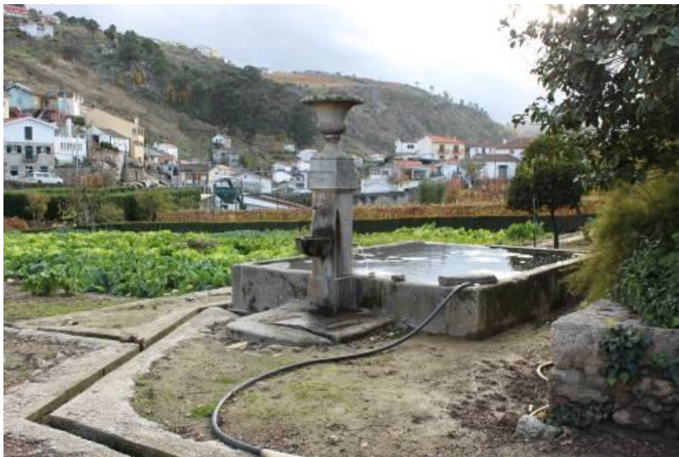
Fig.1081 - Tanque retangular e coluna de granito com duas bicas, rematada com motivo decorativo em forma de taça. Canais em granito de recolha e condução de águas 1083 . Interior da propriedade da Quinta das Brolhas. Datada de 1882. Fotografia da autora.
