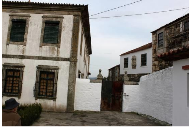
Fig.988- Envoltura da casa da Pousada, com muro, portão e edifícios anexos. Presença de pedra de armas em parede de edifício na propriedade 1016 . Fotografia da autora.
