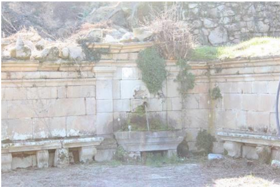
Fig.596 - Fonte de espaldar em granito, inserida em muro, com uma bica de água e estrutura retangular de recolha de águas assente em dois suportes de granito 645 . Muros com bancos corridos em granito. Fonte no exterior, na propriedade da casa do Alvão. Alvelos, Lamego. Fotografia da autora.
