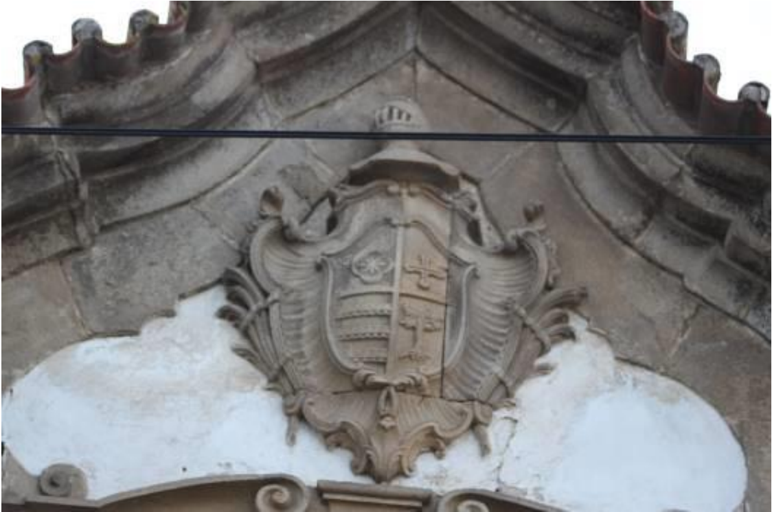
Fig.948 - Pedra de armas da casa do Montenegro 1, junto ao remate do telhado, na fachada principal. Escudo esquartelado: I Carvalho (com diferença: uma brica carregada com um trifólio); II Pereira, III Saavedra, IV Oliveira. Escudo com cartela de volutas e contra volutas concheadas da segunda metade do século XVIII ou inícios do XIX (estilo Dona Maria I) 987 . Armas de Manuel da Trindade Pereira Saavedra e Carvalho, Fidalgo de Cota de Armas em 1789. Fotografia da autora.
