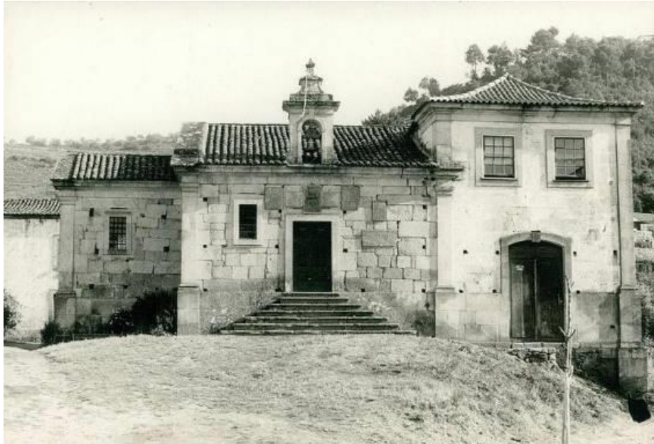
Fig.522 - Fotografia da fachada principal da Capela de São Pedro de Balsemão, virada a norte e esquina que confina com a casa dos Viscondes de Balsemão. Capela adossada parcialmente à casa dos Viscondes de Balsemão. S/d; S/a. 600 .
