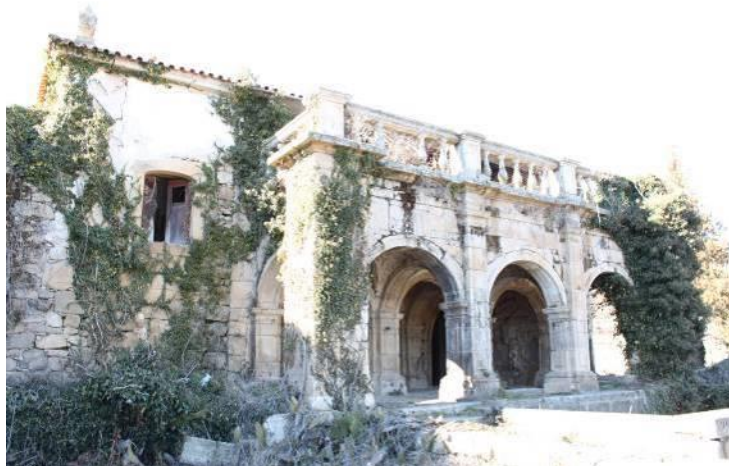
Fig.578 - Fachada posterior com terraço no primeiro piso e galeria no rés do chão, da casa do Alvão. Alvelos, Lamego. Fotografia da autora.
