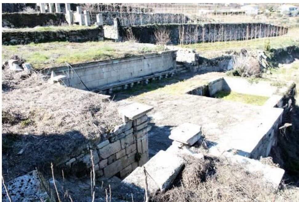
Fig.598 - Envolvência de estrutura exterior na propriedade com fonte, bancos corridos em granito, tanque 646 e lances de escadaria até à casa do Alvão 647 . Alvelos, Lamego. Fotografia da autora.
