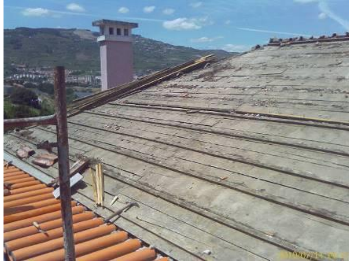
Fig.864 – Vista das obras no telhado da casa dos Varais. Fachada sul (traseira), forro e beiral, em 2010 883 .
