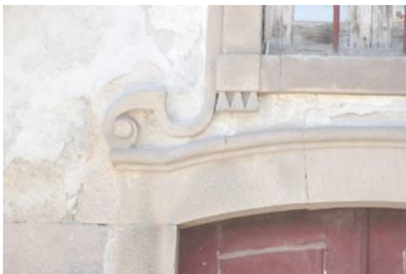
Fig.559 - Ornatos laterais entre a porta e a janela, na fachada da capela da Quinta das Brolhas. Simetria com o outro lado do intervalo porta/janela. Alvelos, Lamego. Fotografia da autora.
