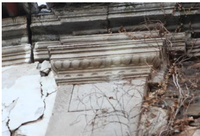
Fig.1054 – Ornatos decorativos no remate superior (junto ao telhado), da pilastra na fachada principal da casa de Angorês 1064 . Fotografia da autora.
