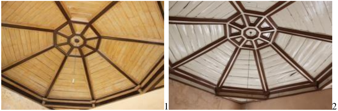
Fig.657 - 1 – Teto em masseira de aposento da casa da Corredoura, 1.º piso. 2 - Teto em masseira de aposento da Casa da Corredoura, 1.º piso. Fotografias da autora.
