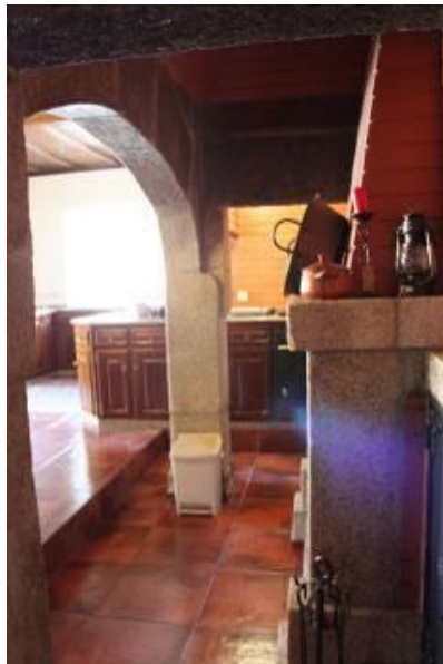
Fig.302 - Cozinha com estrutura de granito delimitando a zona da chaminé. Fotografia da autora.
