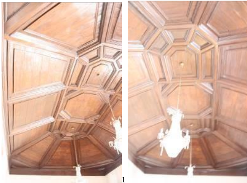
Fig.419 – 1 e 2 - Teto de masseira de um aposento, da casa do Espírito Santo 1 (Clube de Lamego). Fotografias da autora.
