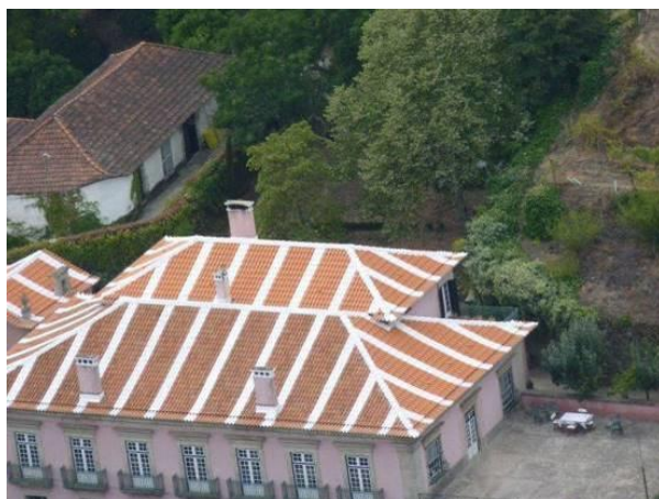
Fig.855 – Vista aérea da casa dos Varais (telhado da casa; telhado da capela destacada; fachada virada para a estrada e lateral) 874 .
