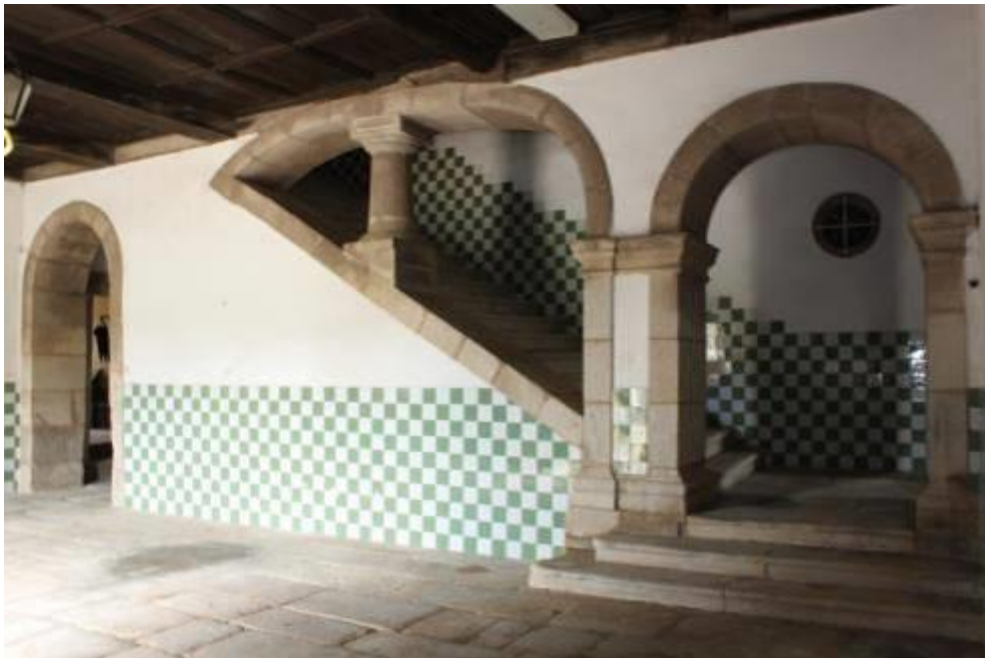
Fig.654 - Zagão no rés do chão da casa da Corredoura. Lance de escadaria interna com arco interrompido com coluna. Porta lateral de acesso a dependências no rés do chão. Fotografia da autora.
