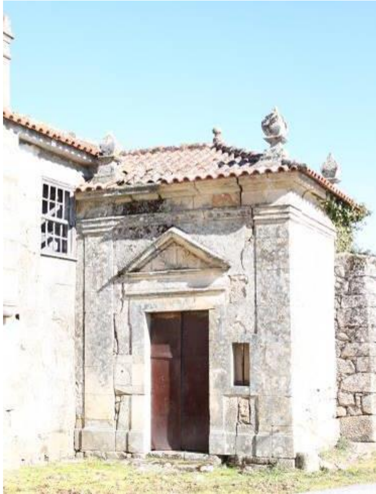
Fig.573 - Fachada principal e lateral da capela da casa do Alvão. Alvelos, Lamego. Fotografia da autora.
