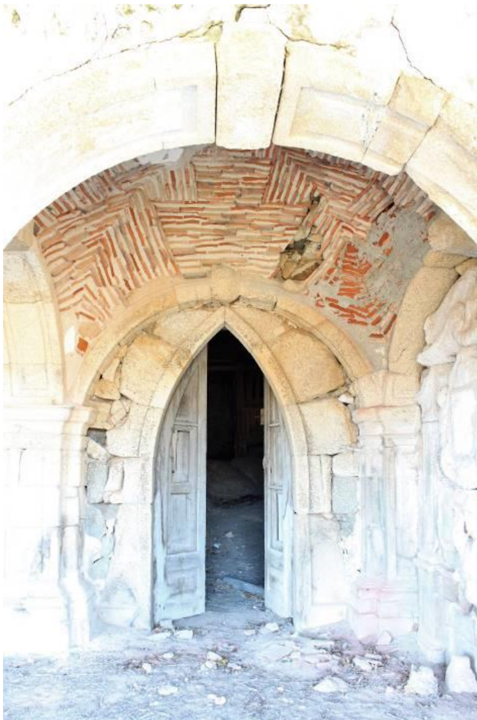
Fig.582 - Porta de acesso do rés do chão, da Loggia para o interior da casa do Alvão 638 . Alvelos, Lamego. Fotografia da autora.
