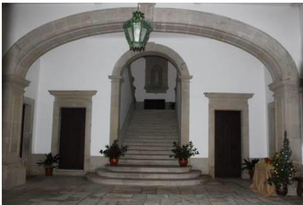
Fig.45 - Zagão de entrada com escadaria interna. Arco rebatido na entrada. Fotografia da autora.
