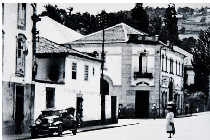
Fig.315 - Casa da Viscondessa de Guiães (do lado esquerdo da foto, de quem olha) 358 . S/d; S/a.
