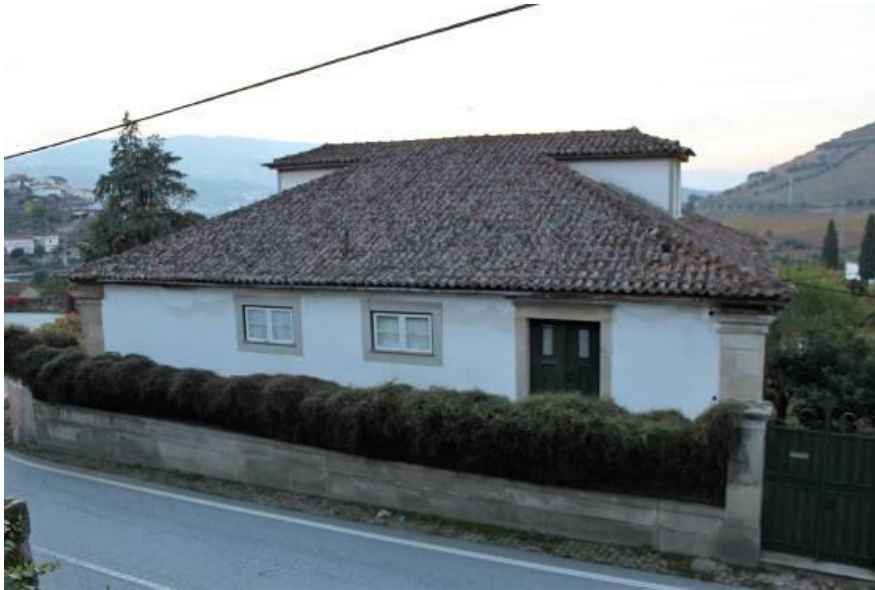
Fig.1097 - Fachada principal da Casa da Quinta do Cabo 1090 . Fotografia da autora.
