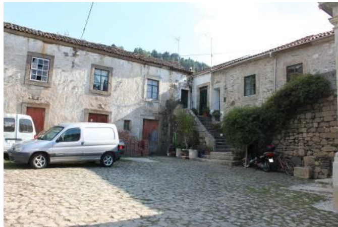
Fig.526 - Fotografia do átrio com escadarias de acesso da casa dos Viscondes de Balsemão, adossada à fachada sul da Capela de São Pedro de Balsemão. Fotografia da autora.
