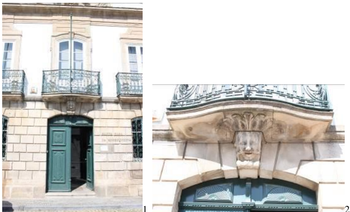
Fig.496 - 1 – Porta encimada por varanda da fachada principal da Casa dos Pereira Coutinho / Casa dos Vilhenas (sede da Santa Casa de Misericórdia). Fotografia da autora. 2 – Pormenor central, mascarão na base da varanda, com ligação à porta principal da Casa dos Pereira Coutinho / Casa dos Vilhenas (sede da Santa Casa de Misericórdia). Fotografia da autora.
