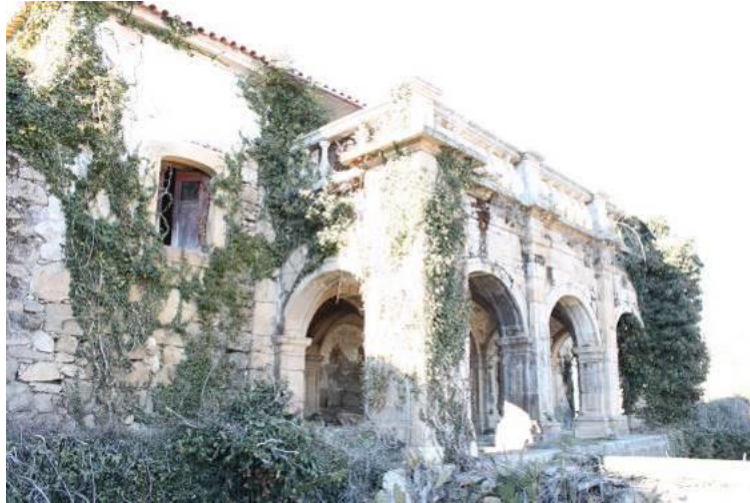
Fig.577 - Fachada posterior com terraço no primeiro piso e galeria no rés do chão, da casa do Alvão. Alvelos, Lamego. Fotografia da autora.
