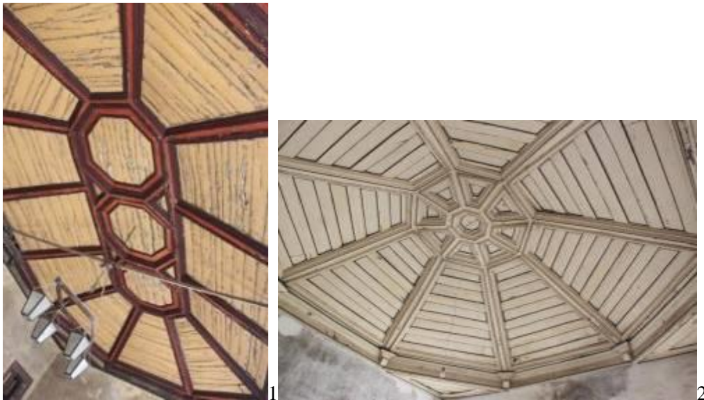
Fig.656 - 1 – Teto em masseira de aposento da casa da Corredoura, 1.º piso. 2 - Teto em masseira de aposento da Casa da Corredoura, 1.º piso. Fotografias da autora.
