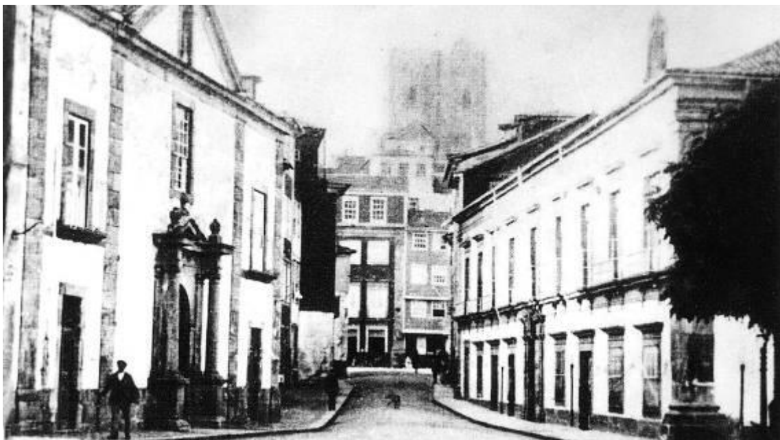
Fig.105 - Fachada da igreja da Nossa Senhora da Graça com pórtico renascentista e Solar Pinheiro de Aragão à direita da fotografia (de quem olha) 131 . S/d; Sem aut
