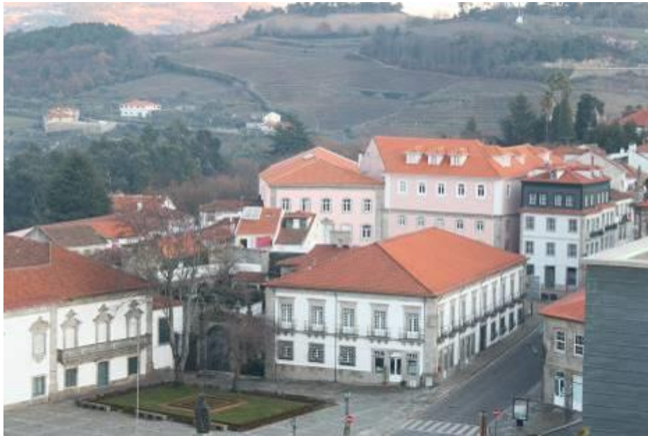
Fig.266 – Vista aérea da Casa dos Mores / Palácio do Capitão-mor. Fotografia da autora.
