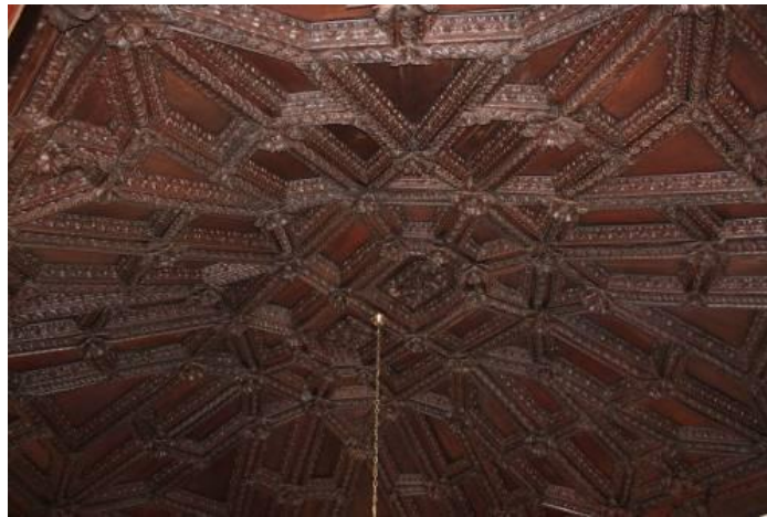
Fig.155 - Teto em masseira com motivos decorativos vegetalistas e geométricos relevados, em salão do 1.º piso, da casa do Assento ou Solar dos Padilhas. Fotografia da autora.
