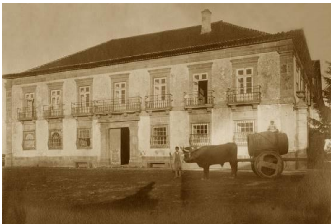
Fig.624 - Fachada principal e parte da lateral virada para o jardim, da casa da Corredoura 688 . S/a. S/d.
