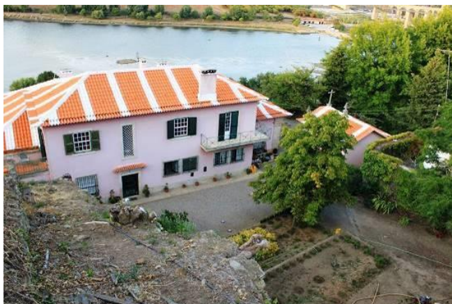
Fig.858 – Fachada posterior da casa dos Varais e da capela 877 .
