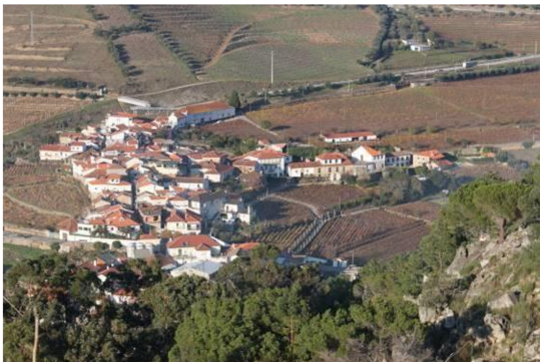
Fig.1073 - Envolvência da casa da Quinta das Brolhas (Residencial) em Valdigem. Fotografia da autora.
