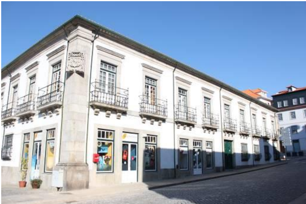
Fig.285 - Fachada principal e parte da lateral (virada para o antigo Paço Episcopal, atual museu de Lamego), da casa dos Mores. Fotografia da autora.
