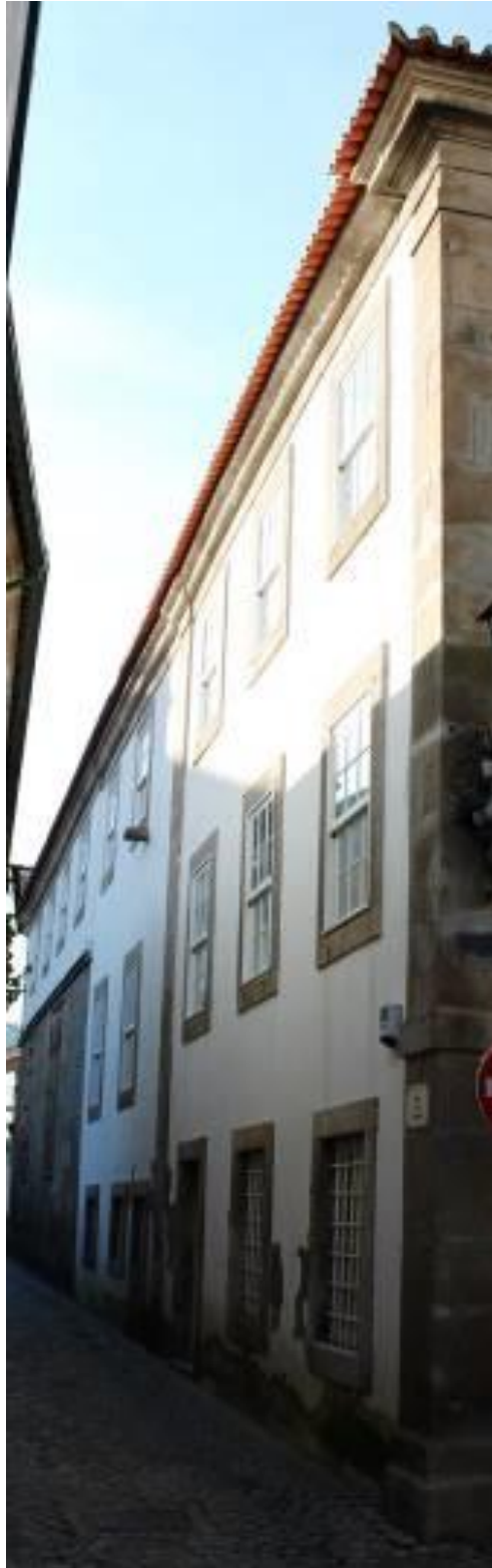
Fig.370 – Casa do Poço. Fachada sul. Fotografia da autora.
