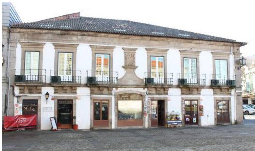
Fig.338 – Fachada principal da Casa da Viscondessa de Guiães, 2013. Fotografia da autora.
