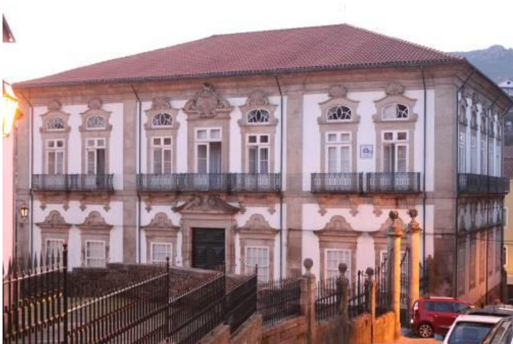
Fig.40 - Fachada principal e lateral da casa dos Sousa Maldonado (atual Paço Episcopal). Fotografia da autora.
