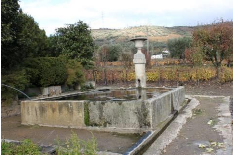
Fig.1080 - Tanque retangular e coluna de granito com duas bicas 1081 , rematada com motivo decorativo em forma de taça. Canal em granito de recolha e condução de águas 1082 . Interior da propriedade da Quinta das Brolhas. Datada de 1882. Fotografia da autora.
