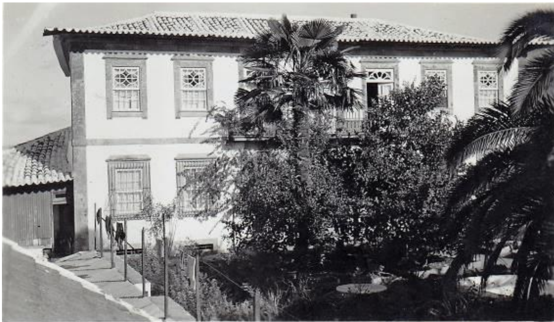
Fig.983 - Fachada principal da Casa da Pousada, com jardim em frente e pequeno edifício anexo na fachada virada para o rio Douro. Telhado de edifício lateral virado para o jardim. Pousada, Penajoia. 11-10-1940. Autor desconhecido. Fotografia cedida pela Dr. a Maria Amália Montenegro 1013 .
