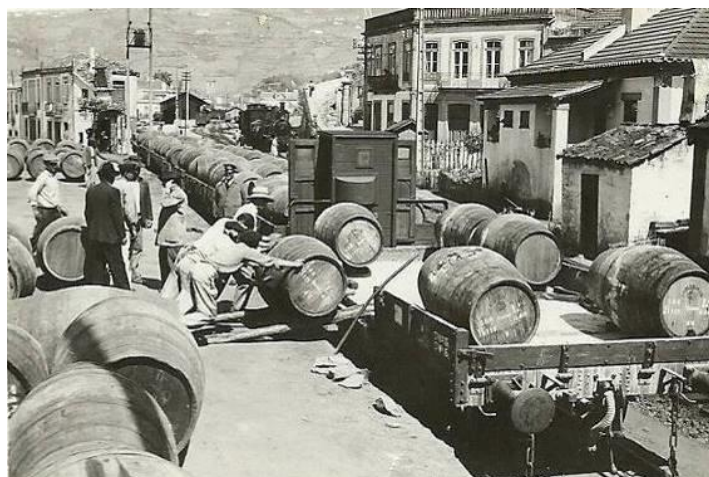
Fig.891 - Estação de caminho de ferro da cidade da Régua. Carga de wagons com vinho do Porto, 1940 909 .
