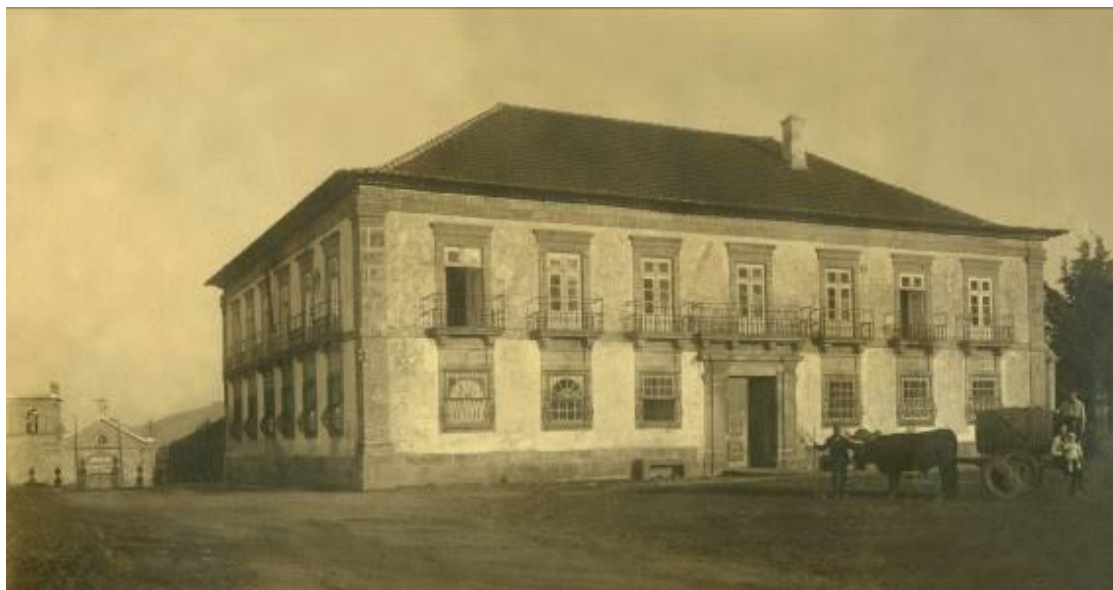
Fig.623 – Fachada principal e lateral da casa da Corredoura. Igreja matriz de Cambres. Cerca de 1900 687 . S/a.
