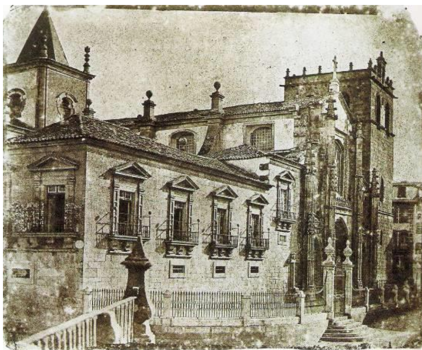
Fig.310 – Vista da fachada da Sé de Lamego 352 , em frente à casa da Viscondessa de Guiães. Sé de Lamego – 1849-1859 – foto de Frederick William Flower.
