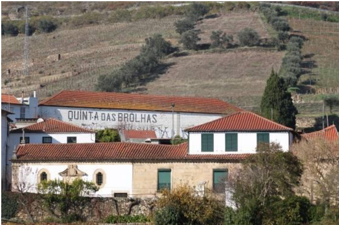
Fig.1074 - Casa da Quinta das Broilhas (Residencial), capela do Desterro (da casa) e armazém de vinificação. Fotografia da autora.
