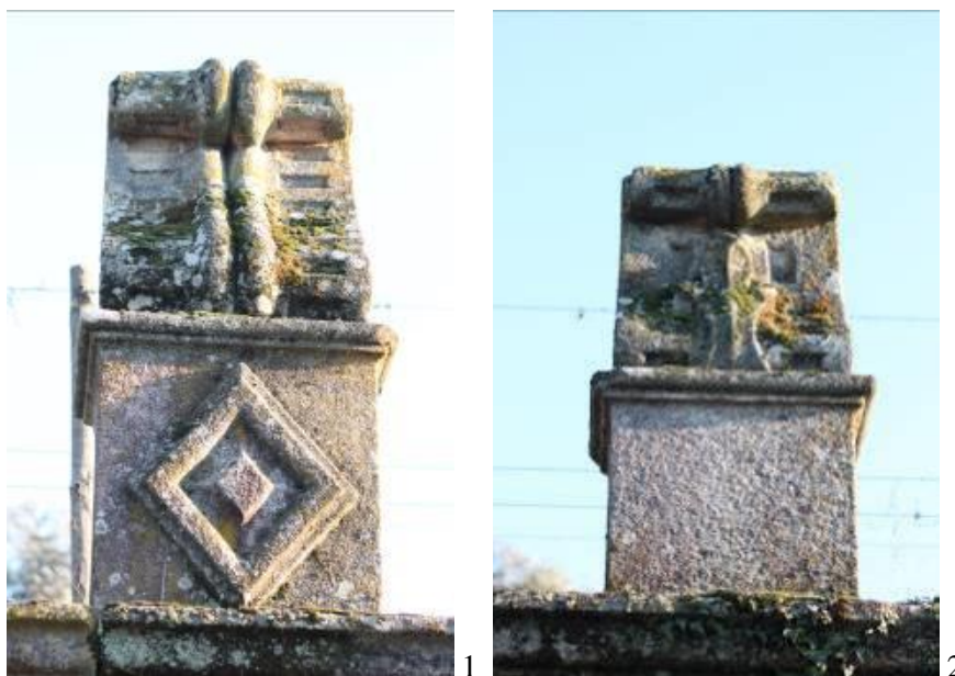
Fig.842 - 1 e 2 - Elementos decorativos nos merlões chanfrados, da parte superior da fonte de espaldar em granito, da Quinta do Mourão. Fotografias da autora.
