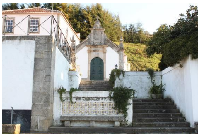
Fig.833 - Lances de escadas e fachada principal da capela, da Quinta do Mourão. Fotografia da autora.
