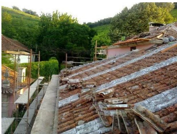
Fig.860 – Vista das obras no telhado da casa dos Varais, em 2010 879 .
