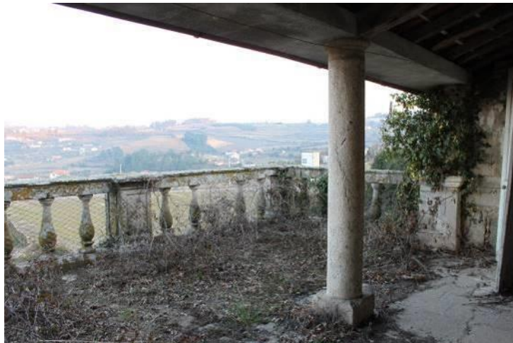
Fig.593 - Terraço / varanda no primeiro piso da casa. Parte posterior da casa do Alvão. Alvelos, Lamego. Fotografia da autora.
