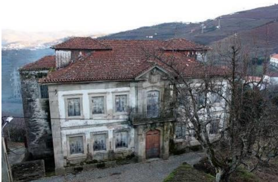
Fig.1025 - Fachada principal e telhado da casa do Conde de Samodães 1045 . Fotografia da autora.
