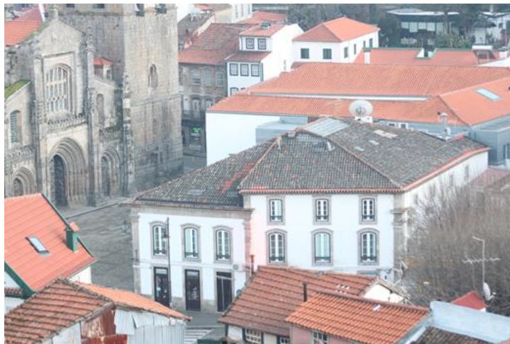
Fig.343 – Perspetiva da fachada lateral da casa da Viscondessa de Guiães, em frente à Sé, vista a partir do castelo. 2013, fotografia da autora.
