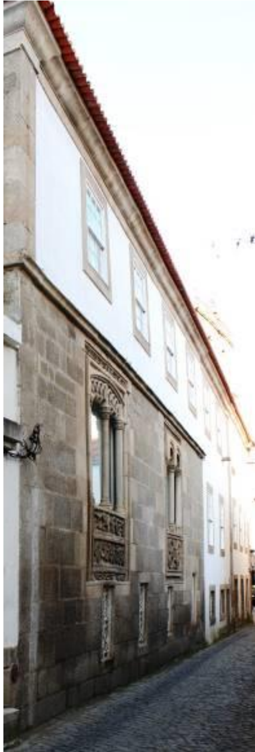
Fig.363 - Corpo do séc. XV- XVI, fachada com janelas Manuelinas, voltada para a rua dos Loureiros. O piso de cima é um acrescento posterior. Fotografia da autora.
