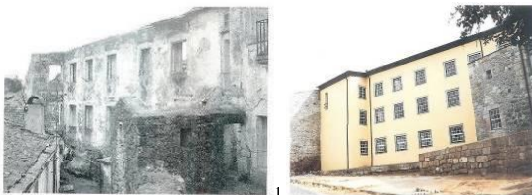
Fig.471 - 1 – Fachada lateral da casa dos Serpas ou casa de Santa Cruz em ruínas 523 . 2 - Fachada lateral da casa dos Serpas ou casa de Santa Cruz depois das obras de recuperação 524
