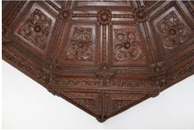
Fig.154 - Pormenor do remate junto à parede, do teto em masseira com motivos decorativos, do teto do salão, do 1.º piso, da casa do Assento ou Solar dos Padilhas. Fotografia da autora.
