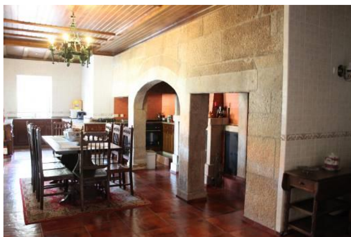
Fig.300 - Cozinha com estrutura de granito delimitando a zona da chaminé. Fotografia da autora.
