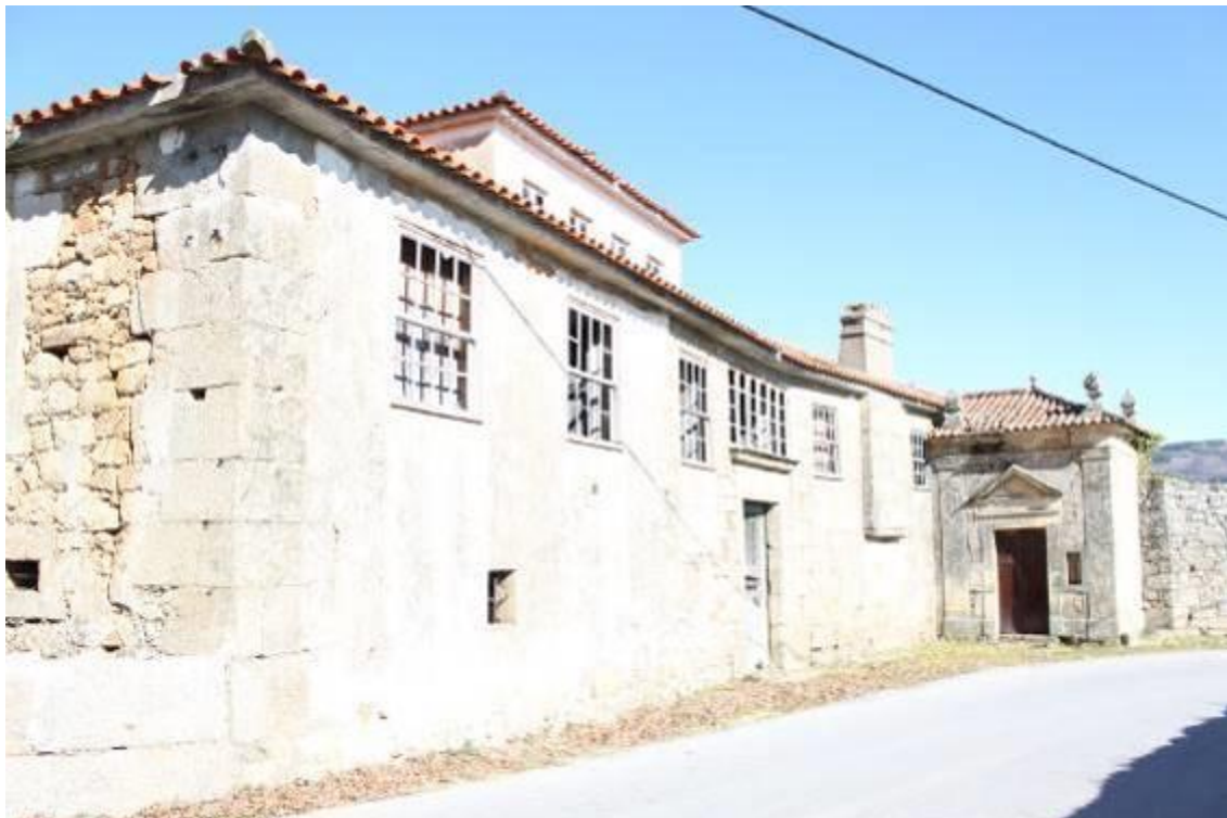
Fig.572 - Fachada lateral e capela anexa da casa do Alvão 631 . Alvelos, Lamego. Fotografia da autora.
