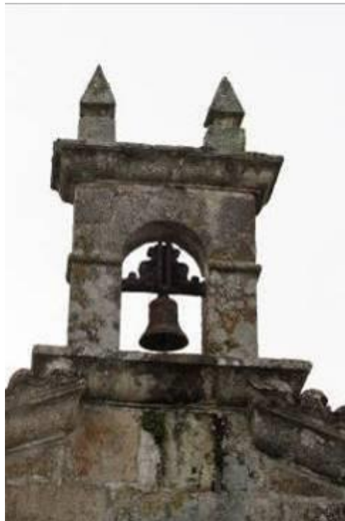
Fig.1000 - Estrutura de granito onde se insere a sineta, ao centro do telhado da capela dedicada a Santo António, da casa da Pousada. Fotografias da autora.
