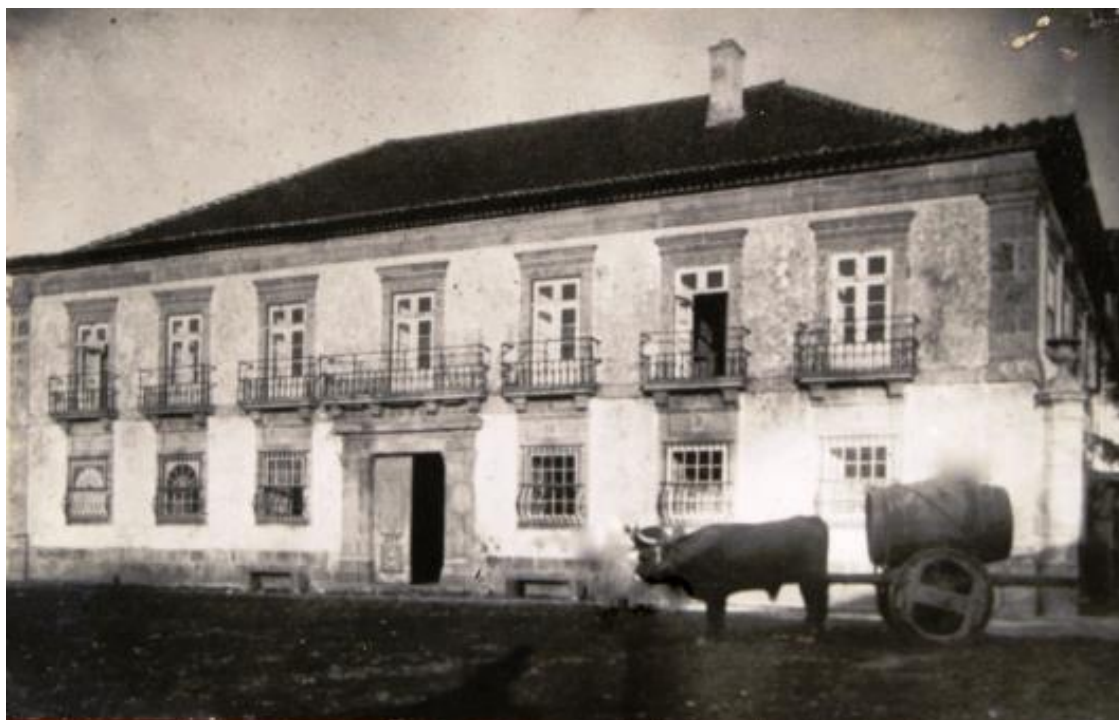
Fig.625 – Fachada principal da casa da Corredoura, com junta de bois e pipa de vinho. S/a. S/d.
