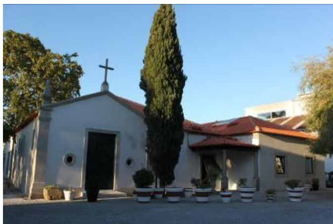
Fig.761 - Obras de reconstrução da capela, em novo local, da Quinta (zona aberta, junto à casa dos antigos Proprietários, família Pimentel). Fotografia da autora (agosto de 2016).
