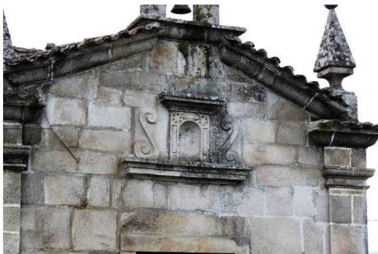
Fig.998 - Pormenor do nicho central ladeado por volutas, ornatos simétricos, da fachada principal da capela dedicada a Santo António, da casa da Pousada 1021 . Fotografia da autora.
