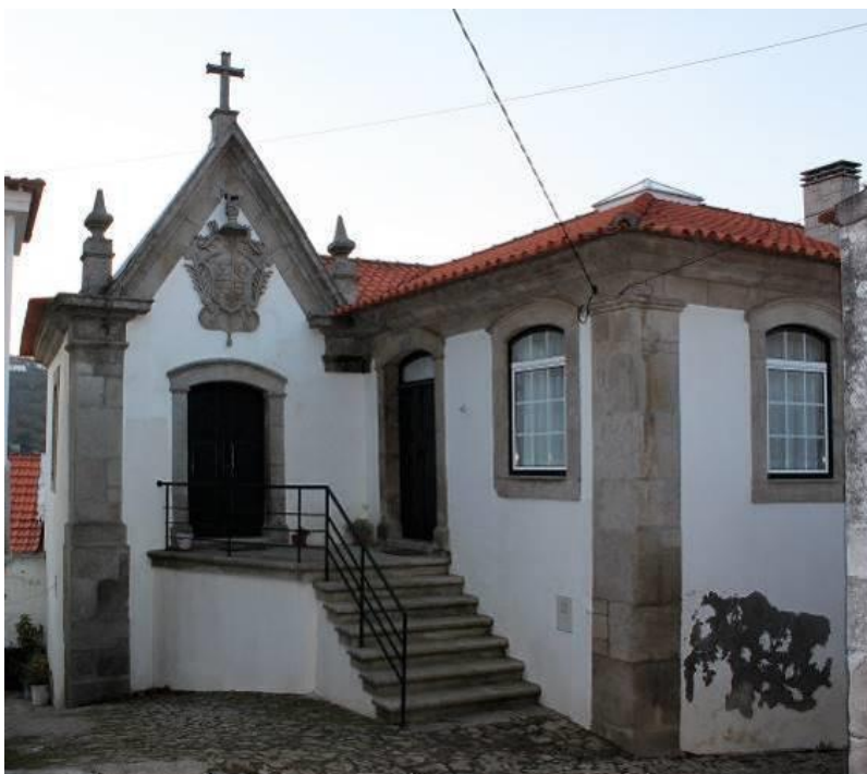
Fig.972 - Fachada da capela e entrada principal da casa do padre da Penajoia. Fotografia da autora.
