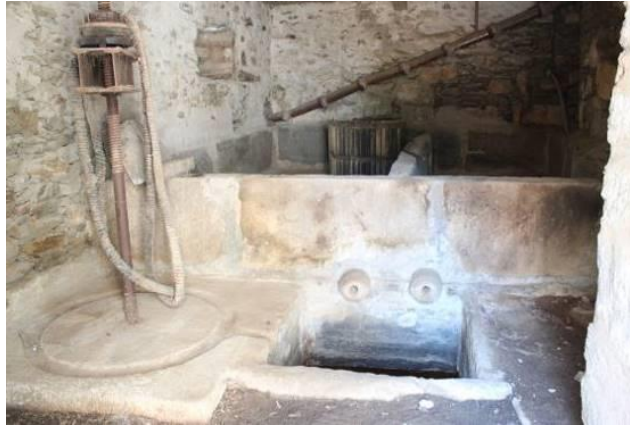
Fig.959 - Lagares no rés do chão da casa do Montenegro 1. Freguesia 993 . Fotografia da autora.
