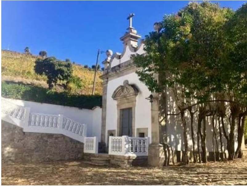
Fig.804 - Fachada principal e lateral da capela de Nossa Sra. da Boa Nova da Quinta da Salada 829 . 6 de novembro de 2017. S/a.
