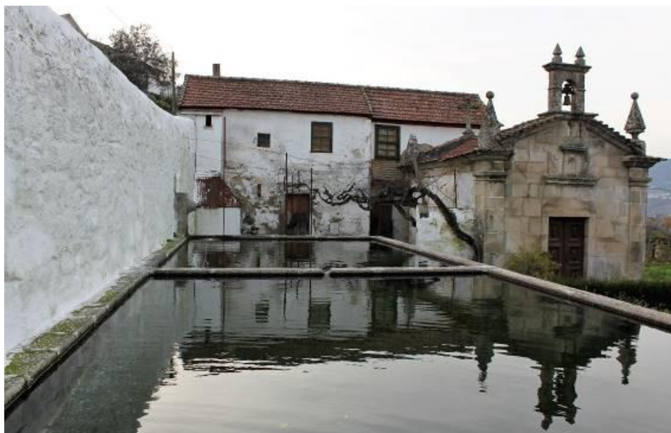
Fig.1007 - Tanques de água, com uma bica, anexos a muro lateral da propriedade da casa da Pousada (junto à capela e à casa) 1029 . Fotografia da autora.
