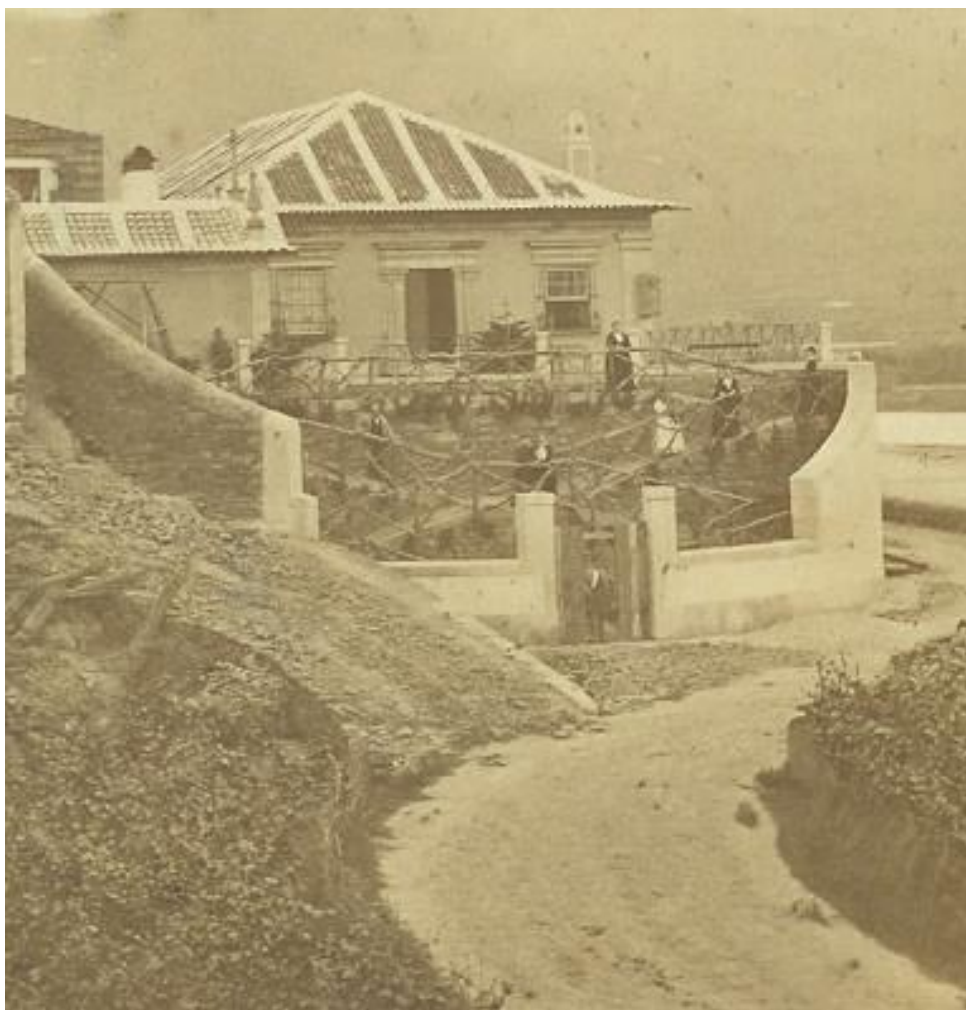
Fig.867 – Casa dos Varais. Fachada principal com capela destacada da casa, do lado esquerdo. Inícios de 1900 886 . S/a.
