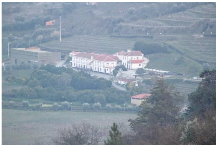
Fig.826 - Envolvência da Quinta do Mourão. Casa, capela, adega, anexos e vinha. Fotografia da autora.
