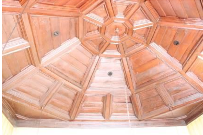
Fig.418 – Teto de masseira de um aposento, da casa do Espírito Santo 1 (Clube de Lamego). Fotografia da autora.
