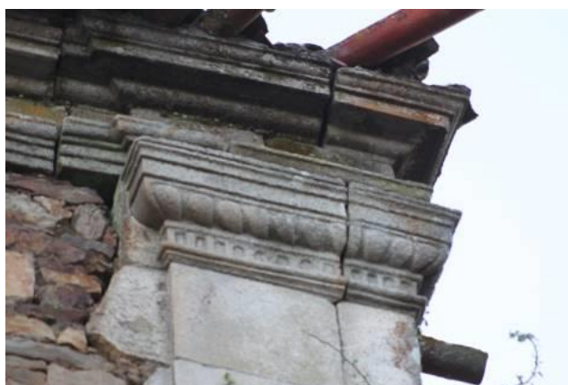
Fig.1055 – Ornatos decorativos no remate superior (junto ao telhado), da pilastra na fachada lateral da casa de Angorês 1065 . “Gárgula” simplificada e não decorativa projetada na parte superior do edifício, na pilastra para escoamento de águas pluviais. Fotografia da autora.
