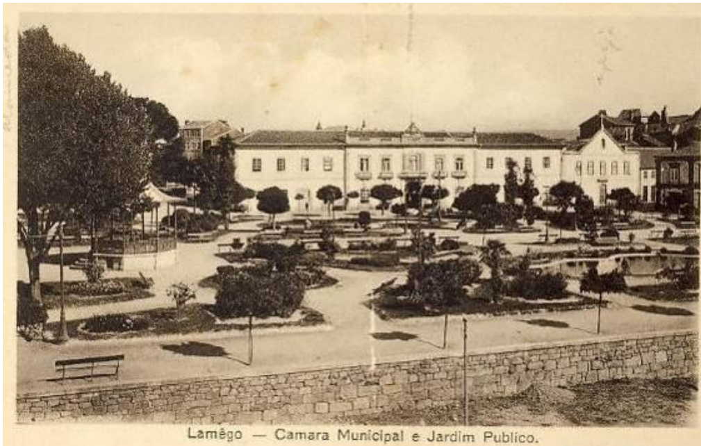
Fig.109 - Câmara Municipal, jardim público, fachada da igreja da Nossa Senhora da Graça já sem pórtico renascentista e Solar Pinheiro de Aragão (extremo direito de quem olha para a fotografia) 135 . S/d.
