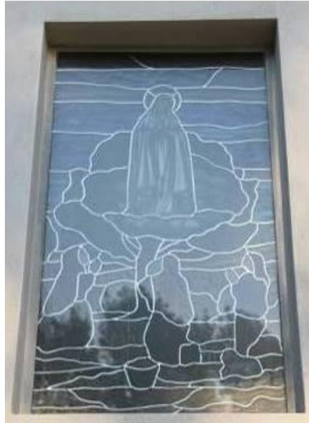
Fig.764 - Janela na Fachada lateral da capela, com Vitral, dedicado à Aparição de Nossa Senhora de Fátima aos Pastorinhos 794 . Obras de reconstrução da capela, em novo local, da Quinta (zona aberta, junto à casa dos antigos proprietários, família Pimentel). Fotografia da autora (agosto de 2016).
