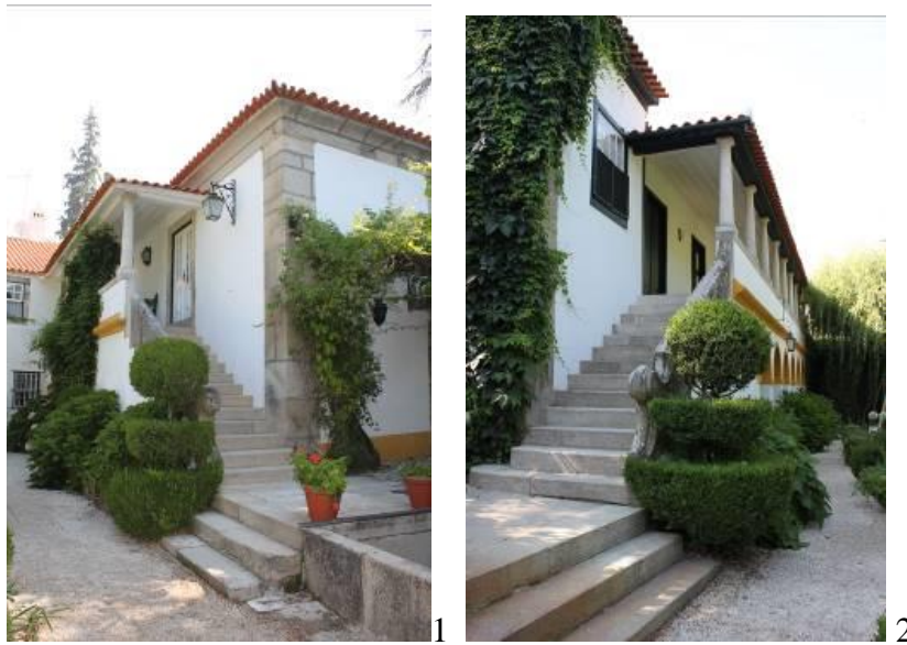
Fig.690 - Aspectos das escadarias de acesso aos dois corpos distintos da casa 752 . Corrimãos findando em volutas. Interior da propriedade. Fotografias da autora.
