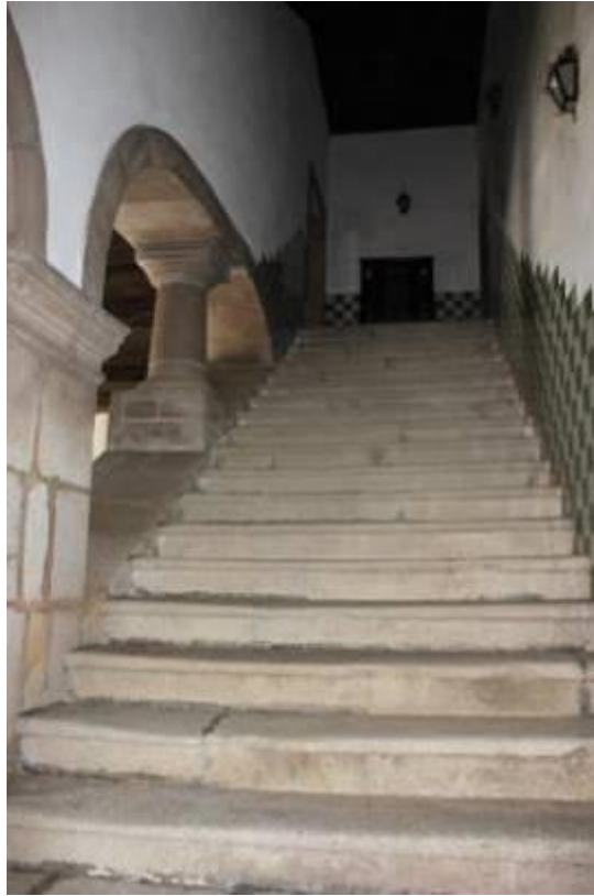
Fig.655 – Escadaria interna de um lance com arco de granito lateral interrompido com pequena coluna, da Casa da Corredoura. Parede lateral com azulejos 715 . Fotografia da autora.
