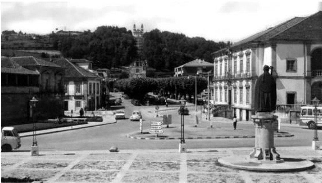
Fig.333 – Envolvência da casa da Viscondessa de Guiães em frente à fachada da Sé, perto do antigo hospital da Misericórdia (atual Teatro Ribeiro Conceição), com Santuário dos Remédios a dominar a cidade 376 . Anos 60, 70 do séc. XX; S/a.
