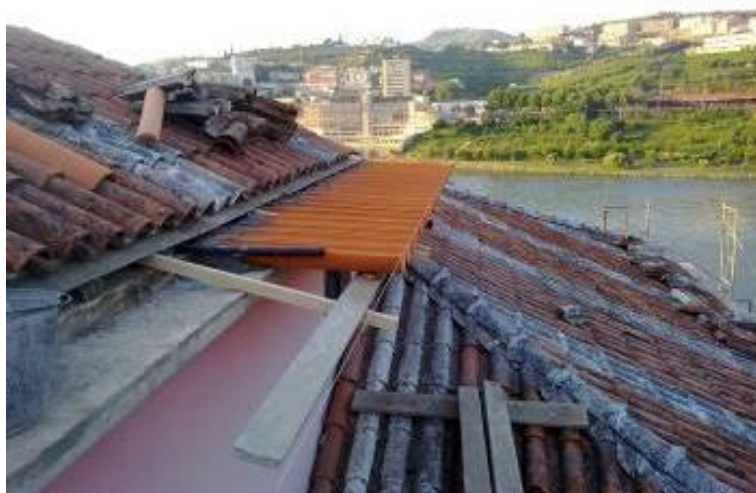
Fig.861 – Vista das obras no telhado da casa dos Varais, em 2010 880 .
