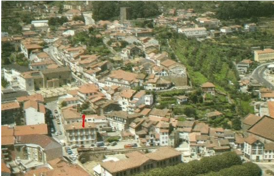
Fig.133 - Vista aérea, Lamego. 1- Casa do Assento ou Solar dos Padilhas (sede região de turismo do Douro Sul) 163 . S/d; S/a.
