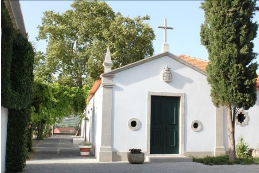
Fig.766 - Colocação/Ostentação de pedra de armas na fachada da capela, em novo local da Quinta (zona aberta, junto à casa dos antigos proprietários, família Pimentel). Fotografia da autora (julho de 2017) 795 .
