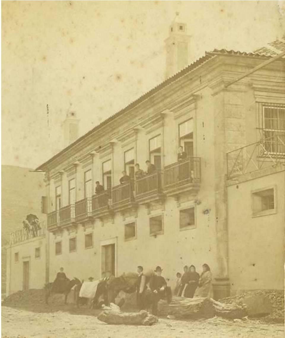
Fig.866 – Casa dos Varais. Fachada virada para o rio Douro e para a cidade de Peso da Régua. Inícios de 1900 885 . S/a.
