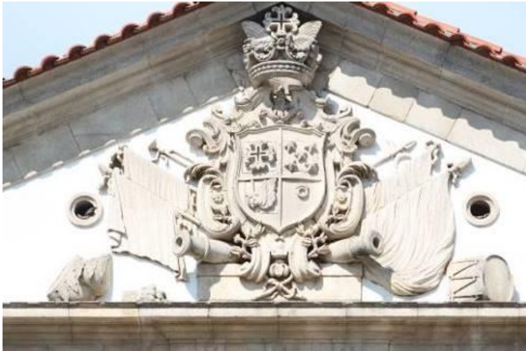
Fig.494 - Pedra de armas no frontão, composto por Coronel de Nobreza, sustentado por 2 canhões, ladeado por 2 estandartes desfraldados e tambores, na fachada principal, da casa dos Pereira Coutinho / casa dos Vilhenas (sede da Santa Casa de Misericórdia). Escudo esquartelado: I Pereira, II Coutinho, III Manoel (de Vilhena?), IV Menezes. Timbre de Pereira. Pedra d'armas de fino recorte de cantaria, com cartela de volutas e folheados á maneira do Senhor Dom João V. Fotografia da autora.
