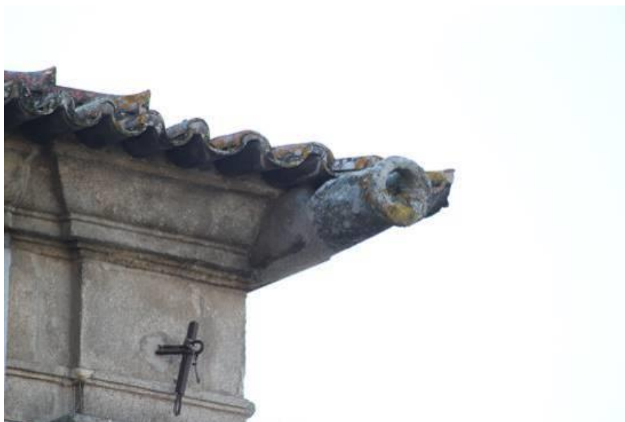
Fig.344 – Gárgula não decorativa projetada na parte superior do edifício, na esquina do beirado do telhado para escoamento de águas pluviais 383 . 2013, fotografia da autora.
