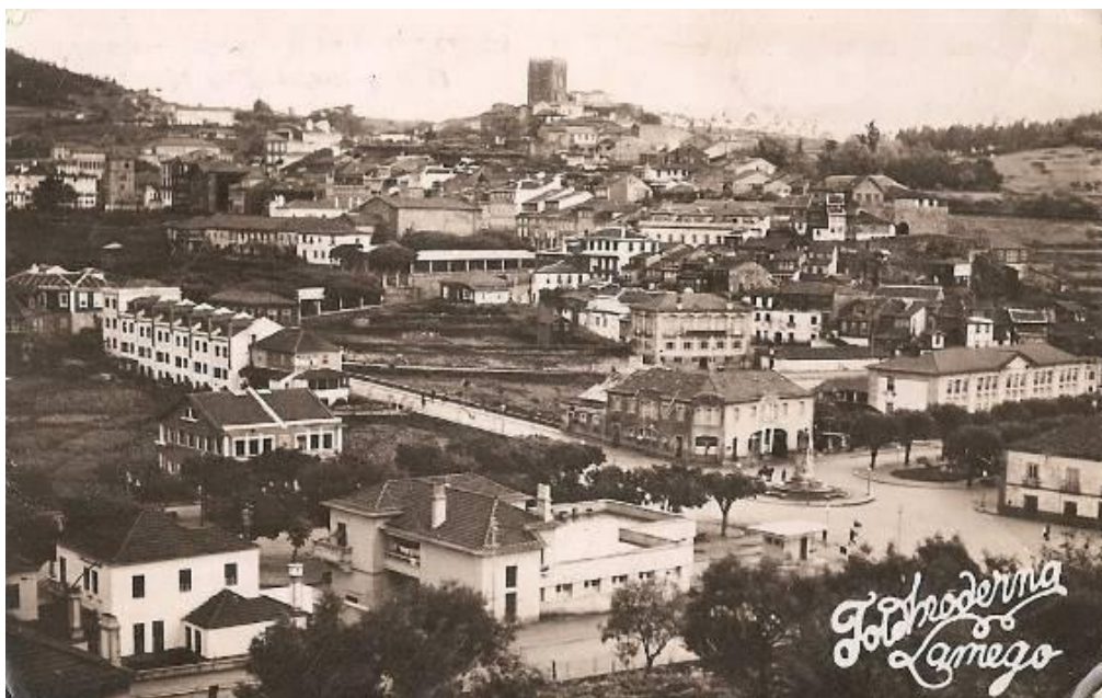
Fig.145 - Vista parcial do Castelo com a casa do Assento ou Solar dos Padilhas, como filial do BNU Lamego (c. 1950). Foto Moderna, Lamego 177 .
