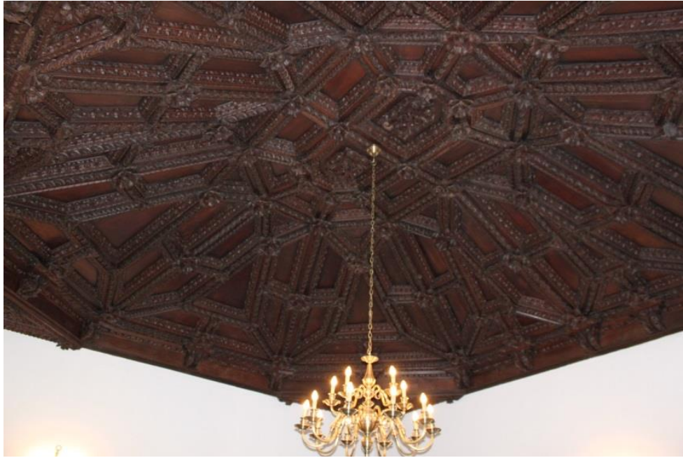
Fig.25 – Teto em masseira com relevo, do salão da casa do Assento ou solar dos Padilhas 397 . Fotografia da autora.
