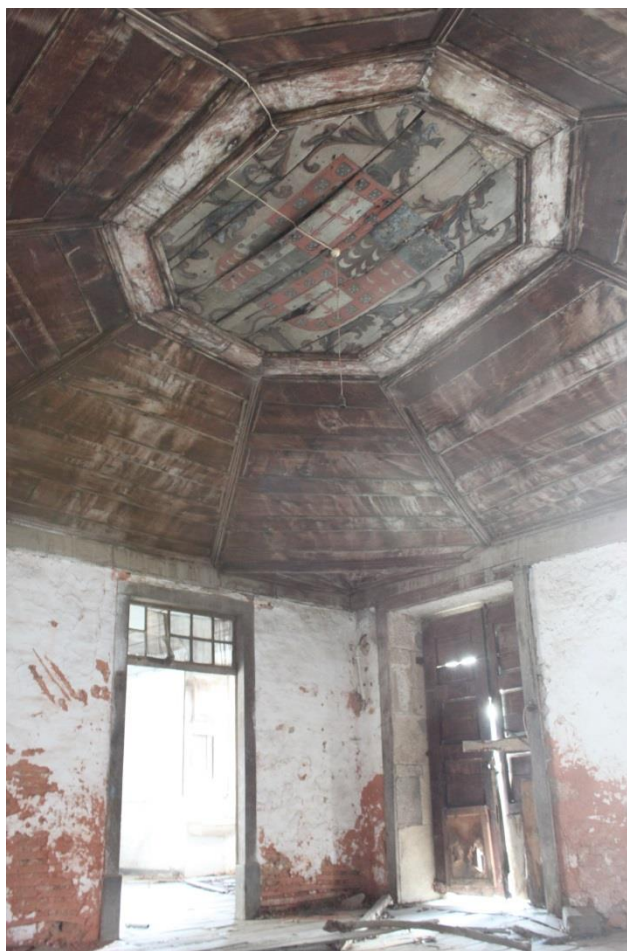
Fig.27 - Teto em masseira com brasão, do salão da casa do Alvão, freguesia de Almacave e Sé (Lamego) 399 . Fotografia da autora.
