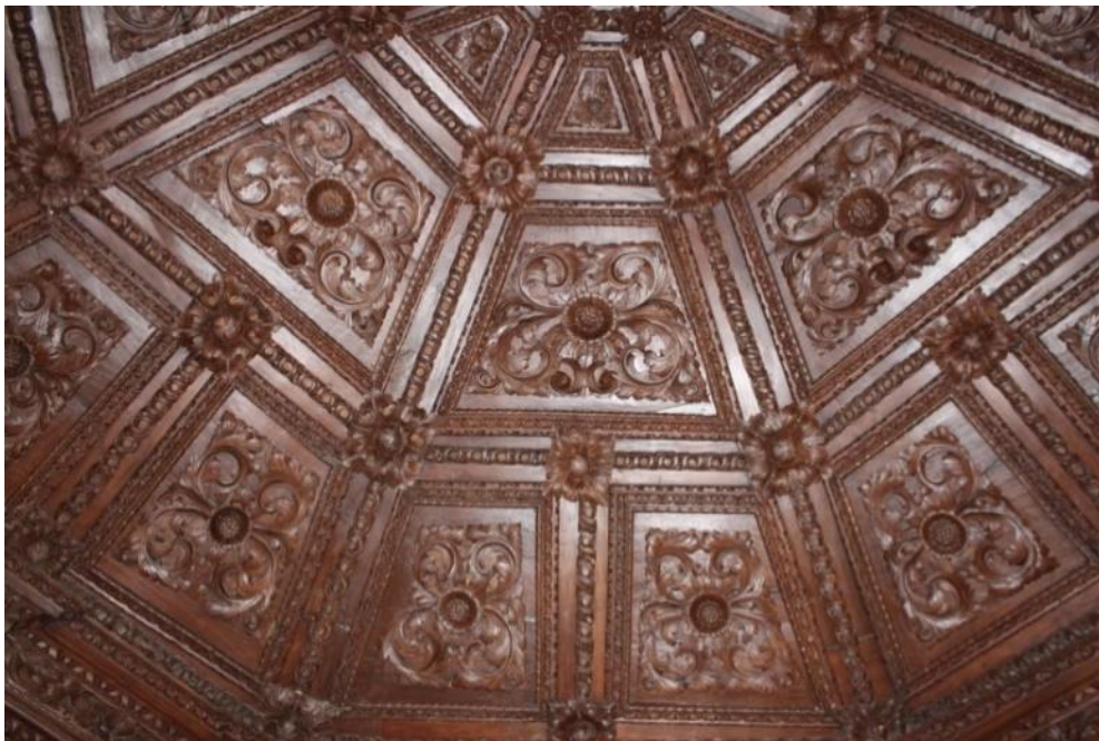
Fig.24 – Teto em masseira com relevo, do salão da casa do Assento ou solar dos Padilhas 396 . Fotografia da autora.
