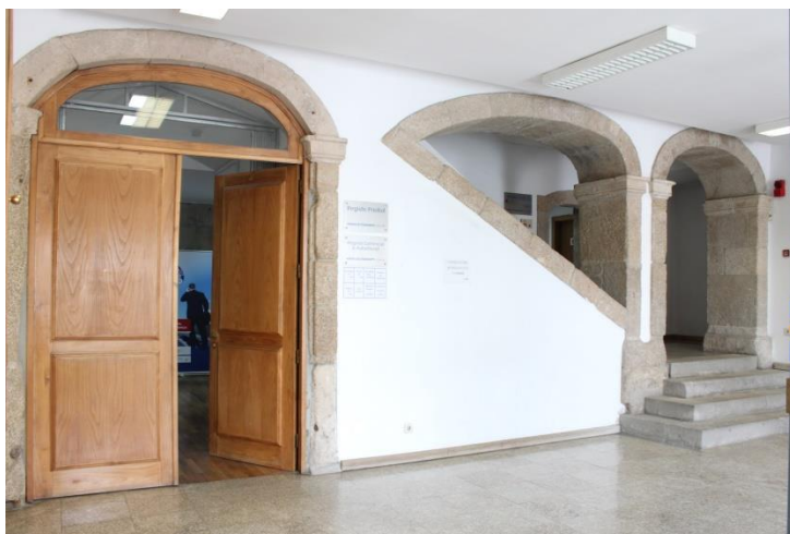
Fig.18 – Escadaria lateral interna da casa dos Serpas ou casa de Santa Cruz, em Lamego. Fotografia da autora.
