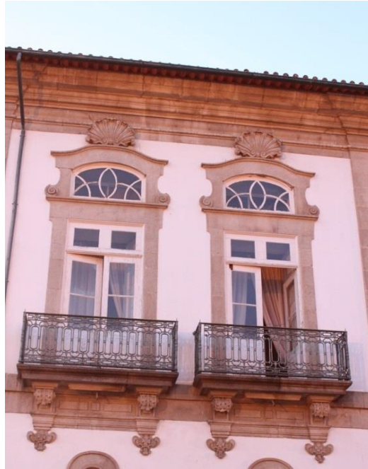
Fig.47 - Varandas da fachada principal da casa dos Sousa Maldonado, Lamego. Fotografia da autora.
