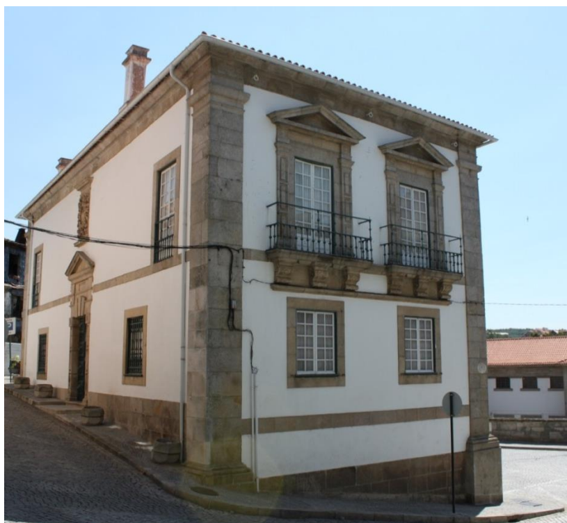
Fig.11- Casa do Assento ou Solar dos Padilhas 377 , com bandas horizontais de marcação dos pisos que segmentam os panos da fachada e agregam os vãos. Fotografia da autora.
