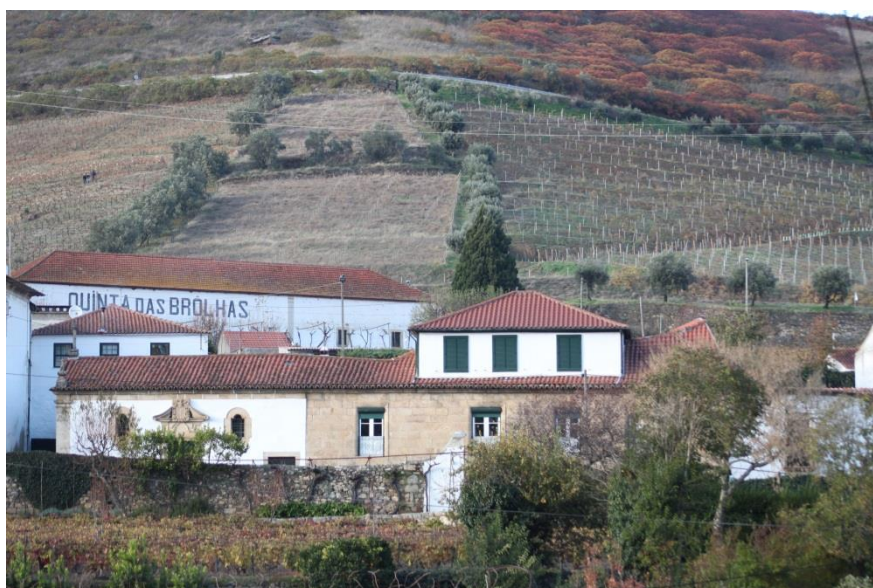
Fig.59 – Casa, capela e armazém vitivinícola da quinta das Brolhas. Fotografia da autora.
