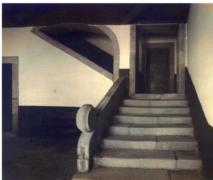
Fig. 20 – Escadaria com lance frontal e lateral interna da casa da rua da Seara, em Lamego. Fotografia de Arquivo Particular da Família Paiva.
