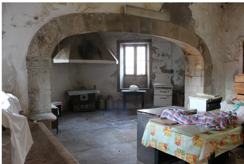
Fig.21 – Cozinha com arco em granito, e zona de fogão e lareira, da casa das Brolhas, na união das freguesias de Almacave e Sé (Lamego). Fotografia da autora.
