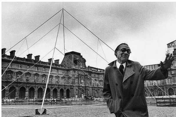
Figura 6. I. M. Pei quando da simulação de pirâmide do Louvre com recurso a cabos tensionados elevados por grua (1985).
