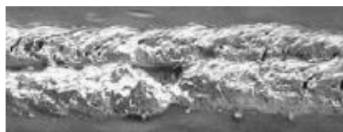
Figura 2.27 – Porosidade em soldadura (CMM, 2016)
